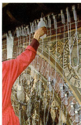
Consolidatie van de onderste pleisterlaag door injecties Moreaustraart 170, Anderlecht
