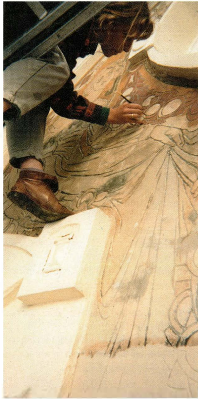
Herstelling met kalkmortel van de gecementeerde gedeeltes Jachtaan 141, Etterbeek
