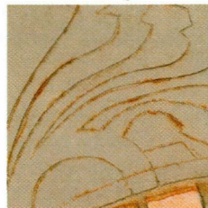
Ingriffen van de lijnen in de verse pleisterlaag Herkoliersstraat 35, Koekelberg
