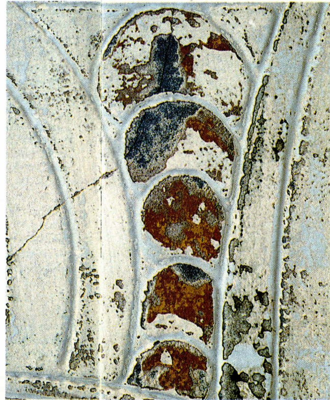
Overschildering van de oorspronkelijke verflaag Jachtlaan 170, Etterbeek
