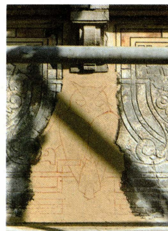
Tekenen van de omtreklijnen op de bepleistering
