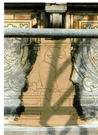
Ingriffen van de lijnen in de verse pleisterlaag
