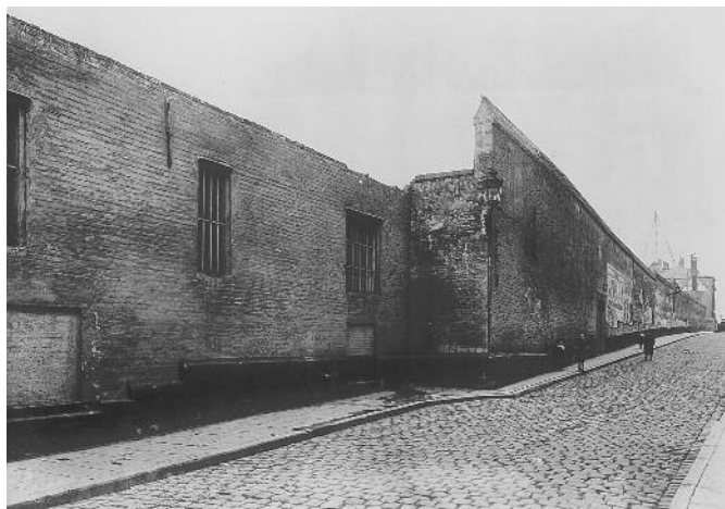
Een lange muur in het verlengde van het kleine hotel van Luxemburg scheidde het park van de Wolstraat. Deze muur maakte in het begin van de 20ste eeuw plaats voor de huidige zesentwintig huizen.
