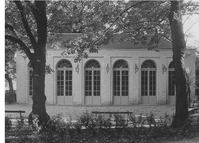
Zoals gebruikelijk voor een orangerie gebeurt de verlichting langs de zuidkant door middel van zes vensterdeuren met rondboog.
