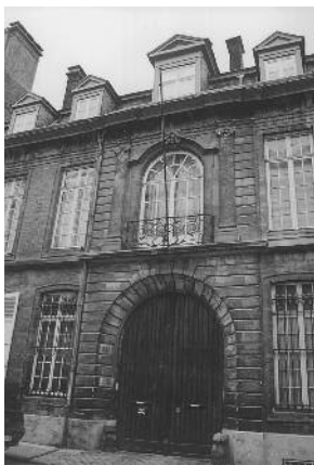
De axiale travee van het hotel de Lannoy is geaccentueerd door decoratieve schijnvoegen.
