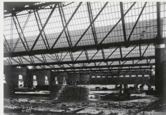
Het skelet van entrepot A is voltooid en de zuidelijke dakhellingen van de sheds zijn al met dakpannen bedekt. (© SAB)
