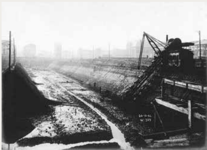
In het tweede deel van de uitgravingen voor het pakhuis is een baggergraafmachine waarvan de ketting met emmers wordt aangedreven door een stoommachine, bezig het talud af te schuiven door er sleuven in te graven. De met aarde en puin gevulde emmers worden achter de graafmachine uitgestort. (© SAB)
