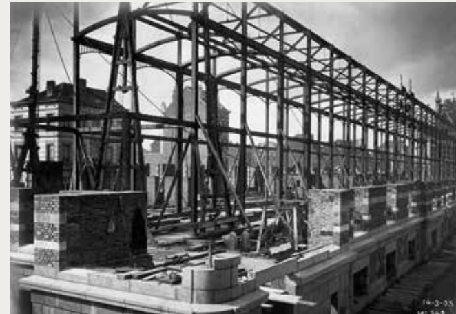
Bouw van het metalen skelet van de centrale hal van het douanegebouw. (© SAB)
