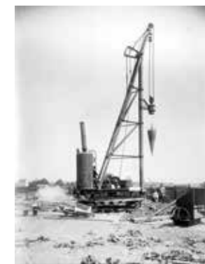
Het houten of metalen geraamte van een heilmachine dat diende als geleider voor een zwaar (giet)ijzeren gewicht, 'mouton' genaamd. Dit gewicht, dat meerdere meters omhoog werd gehesen door een stoommachine en vervolgens in vrije val neergelaten, dreef met zijn 1.200 kg geleidelijk de lange houten heipalen de grond in, bestemd om de funderingen in de zeer vochtige ondergrond van de site te stabiliseren. (© SAB)
