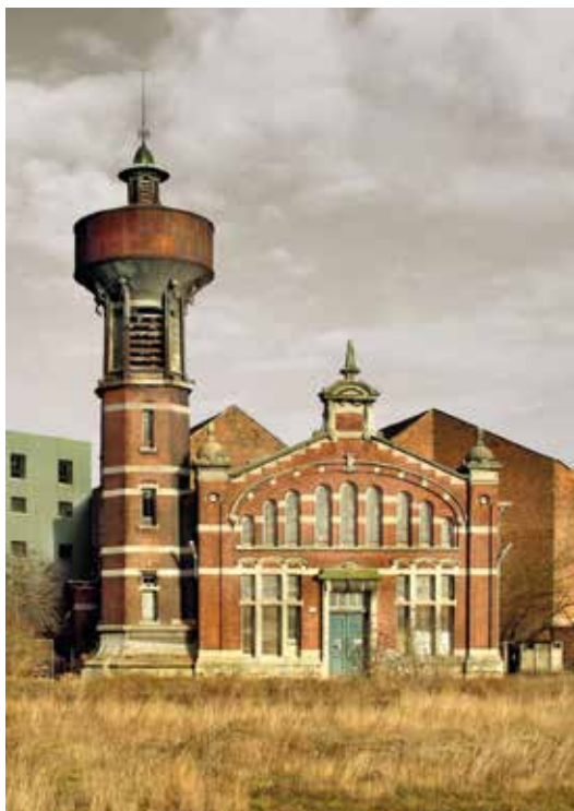
De elektriciteitscentrale en de watertoren. (G. De Kinder © GOB)
