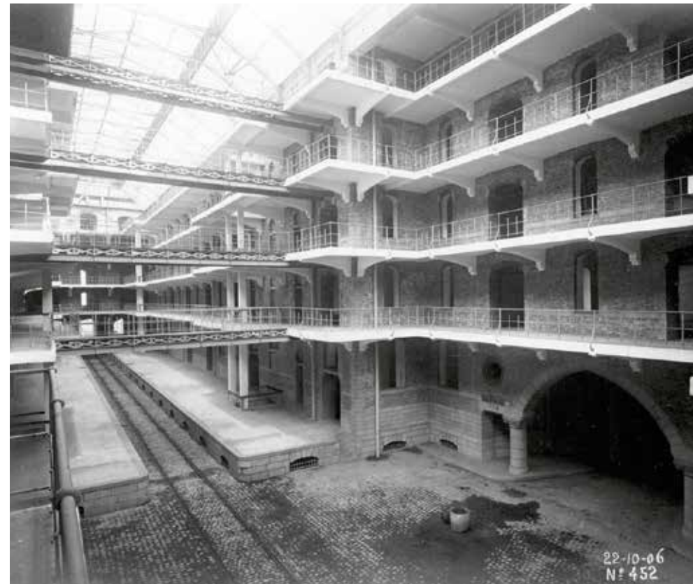
Oktober 1906: het interieur van het Koninklijk Pakhuis met zijn over vier niveaus omlopende galerijen in de afwerkingsfase. (© SAB)
