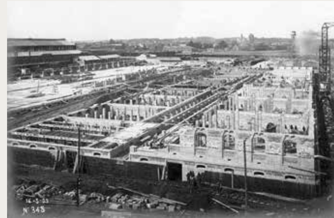
De funderingen van het Koninklijk Pakhuis zijn voltooid, evenals een deel van het metselwerk van de benedenverdieping. Links, langs het goederenstation, is de vloer van het toekomstig entrepot A zichtbaar. In de verte tekent zich het silhouet af van de kerk van Laken. (© SAB)
