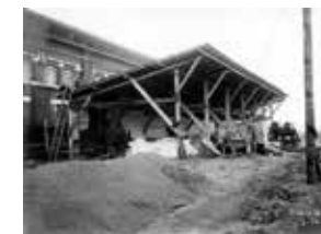
Installaties voor het elektrisch malen van mortel. (© SAB)
