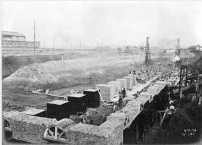
De eerste bakstenen pijlers van het Koninklijk Pakhuis in opbouw terwijl op de achtergrond heimachines funderingspalen in de grond drijven. (© SAB)
