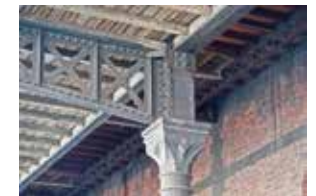
Kapiteel van een van de kolommen die het dak van het perron dragen. (A. de Ville de Goyet © GOB)
