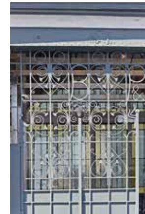
Detail van het toegangshek. (A. de Ville de Goyet © GOB)
