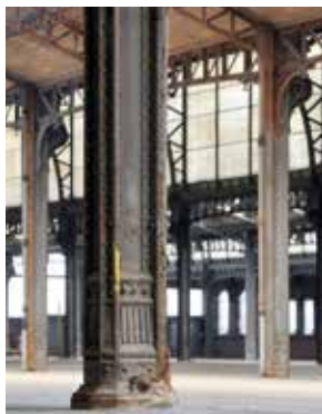
Zicht op de hal van het goederenstation. (verz. Belfius Bank - Académie royale de Belgique © ARB-GOB)
