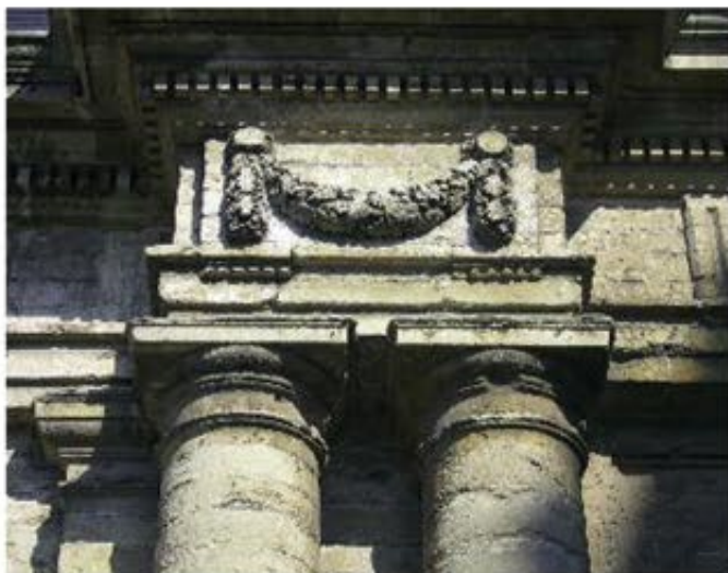
Halfzuilen van de portiek van de abdij.
