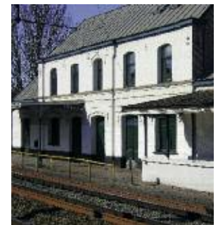
Het kleine station van Vorst-Oost werd gebouwd in de jaren 1870 en bediende toen 3.500 Vorstenaars, voor het merendeel inwoners van het oude dorp.
