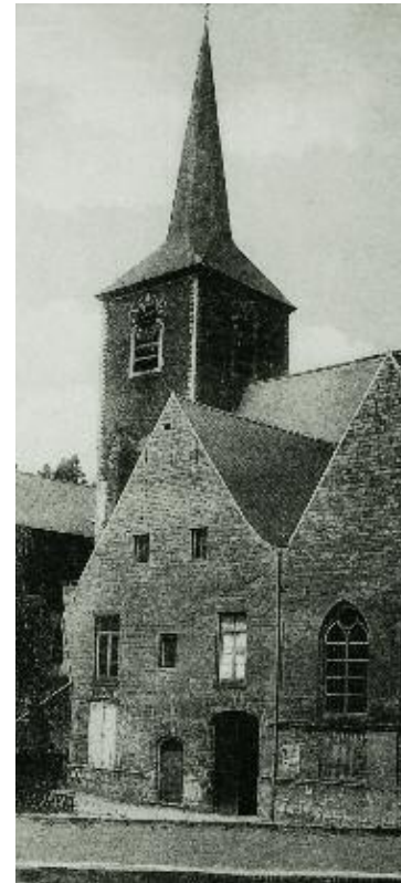
De zuidkant van de kerk vóór de restauratie. Het Geesthuis heeft dezelfde puntgevelstructuur als de aanpalende Sint-Jozefkapel en verduistert de hoge vensters van het schip.
