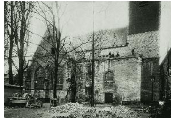
De noordelijke zijbeuk tijdens de restauratie van 1925-1926.
