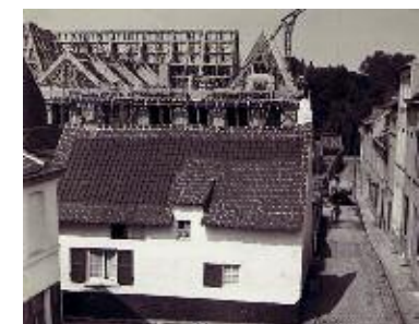
Het gemeentehuis in aanbouw (omstreeks 1935), gezien vanuit de Barcelonastraat in de richting van de Omer Denissquare.
