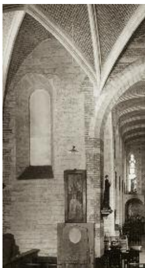
In de westelijke muur van de kapel is een oud romaans rondboogvenster bewaard.
