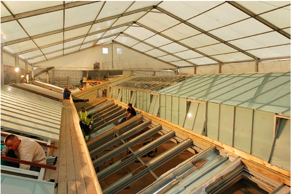
De renovatie van de bedaking.
