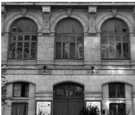
De vroegere tekenzaal op de verdieping kreeg licht via grote boogvensters.
