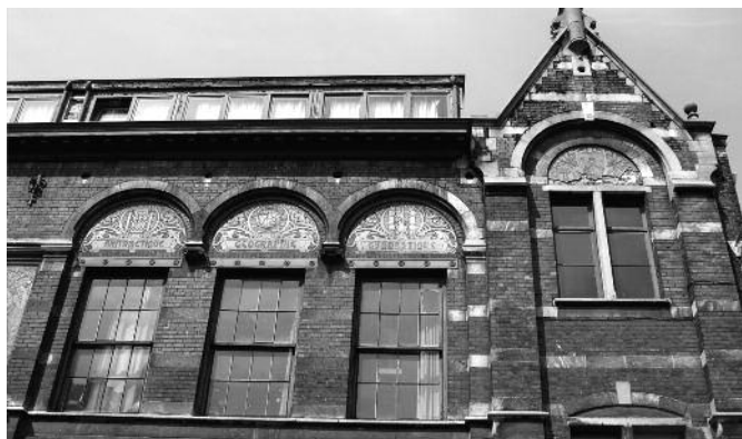
Gemeenteschool nr 8 tussen de Odonstraat en de Pastoor Cuyllitsstraat.
