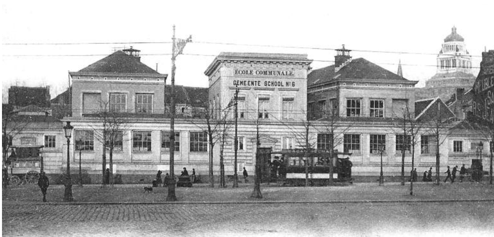
Eerste gebouw specifiek ontworpen voor het onderwijs (1850).
