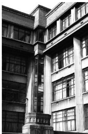
Het Athénée Royal van Koekelberg: gemengd gebruik van natuursteen, bakstenen en stalen raamlijsten voor de zijgevels.
