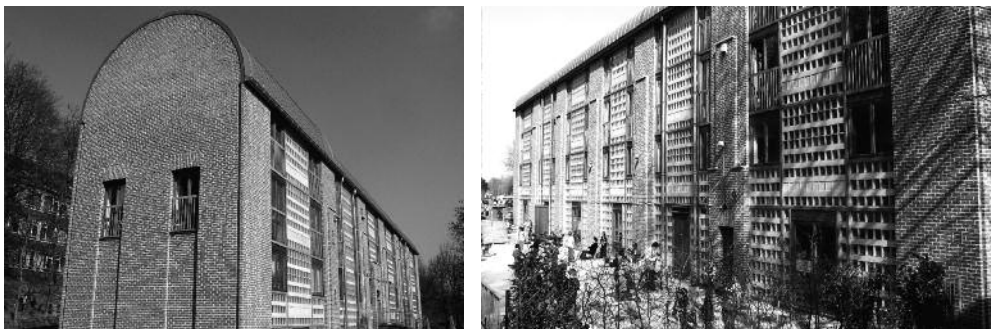
De Anderen school: de klassen als treincoupés en het ronde zinken dak zijn uitdrukking van een speelse architectuur die verwijst naar het verleden.
