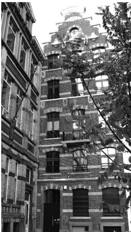
De turnzaal werd later door architect Edmond Quéétin bijgebouwd aan het Rouppeplein.
