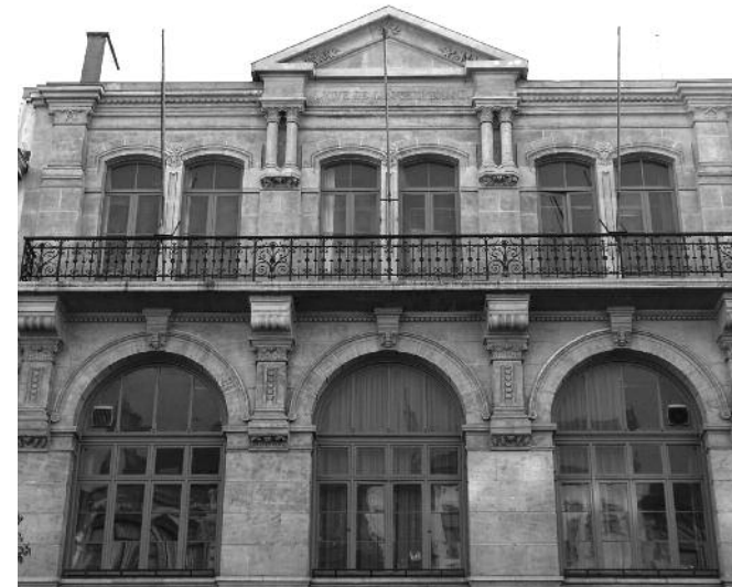
De gevel van de Modelschool werd bekroond in de wedstrijd voor de verfraaiing van de centrale lanen na de overwelfing van de Zenne.
