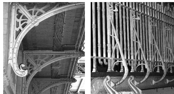
Draagconsoles van de galerij rond de overdekte speelplaats.
