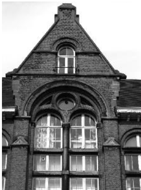
Topgevels en rozetvensters van de gevels.
