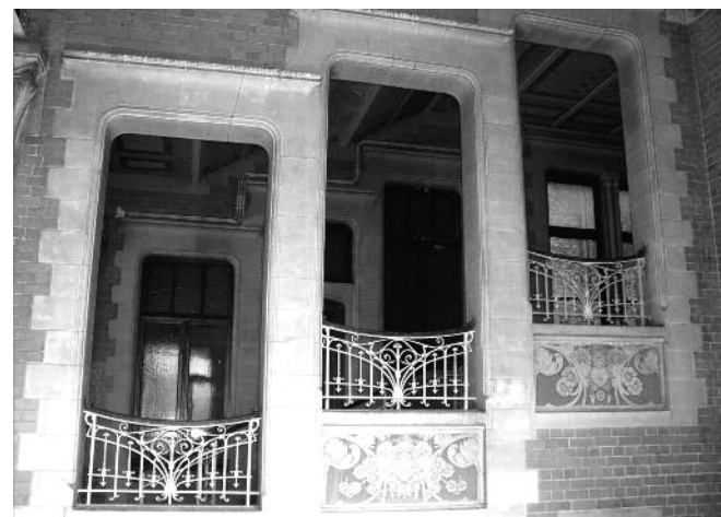
Balustrades en vensterdammen van het trappenhuis.
