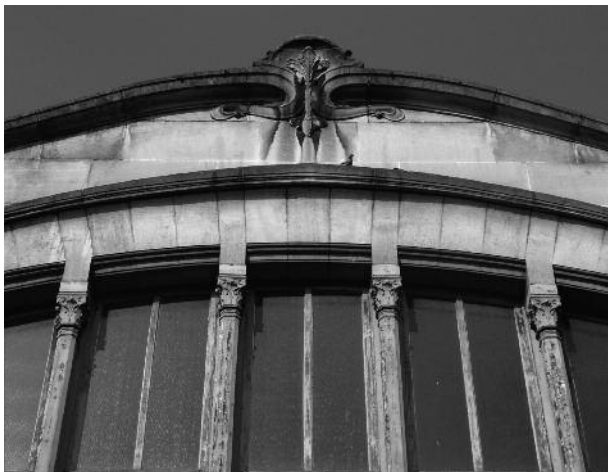
Gevel van de turnzaal met grote ramen.
