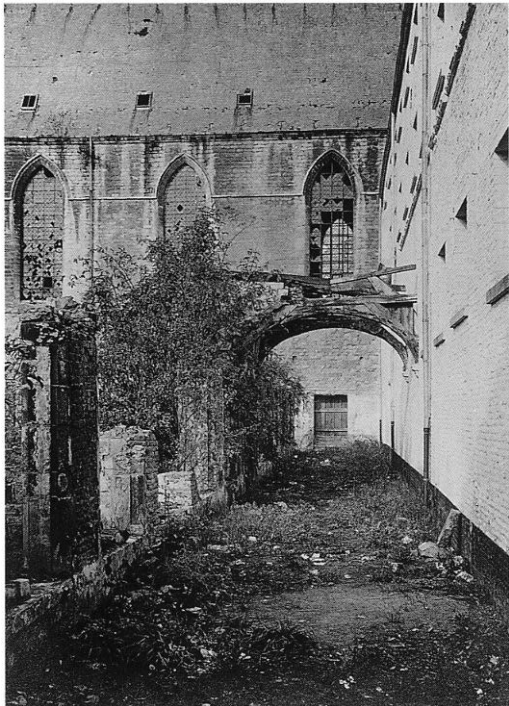
De muur van de refertvleugel is gesloopt door het leger.
