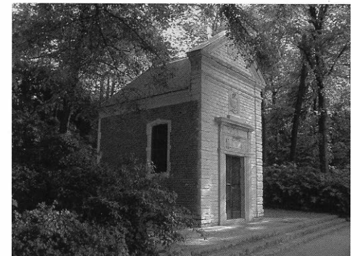
De Sint-Bonifatiuskapel na de restauratie.
