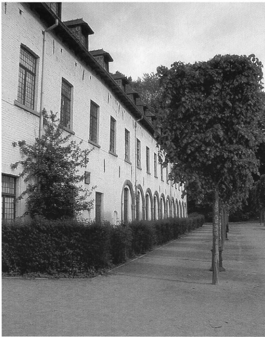
De booggewelven zijn dichtgemaakt en het lage dak is vervangen door een mansardedak.
