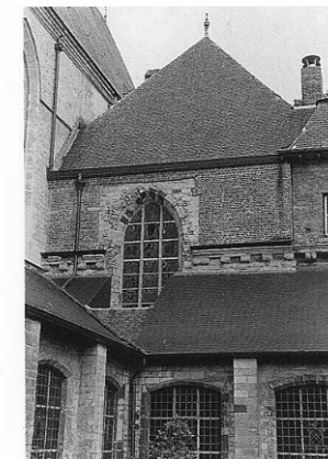
De stenen kroonlijst in Romaanse stijl, overblijfsel van het primitieve klooster uit de 13de eeuw.
