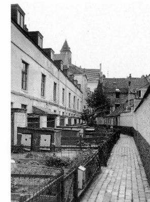
Carré Vannot , Goffartstraat. Omstreeks 1850 telde hoog-Elsene een tiental impassen en carrés , die heden allemaal verdwenen zijn zoals de Londengang, de carré Vannot , de Waverse carré en de carré Dambre . De laatste getuige, de carré Vannot , waarvan de toegang zich tussen de nummers 46 en 48 van de Goffartstraat bevond, bestond uit tweeëntwintig arbeidershuisjes die rug tegen rug stonden langs twee impassen . Ze werden bewoond tot 1980, vijf jaar later verdwenen ze onder de sloophamer.
