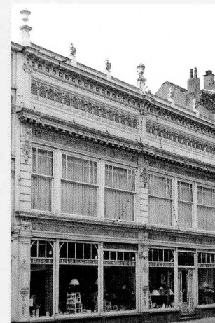
Gevel van de voormalige porseleinfabriek Demeuldre-Coché, opgetrokken in 1905 door architect Maurice Bisschops.
