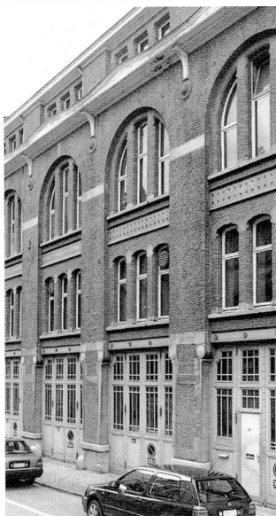
De brandweerkerke en haar fraaie gevel met polychrome bakstenen en ceramieken tegels (Viaductstraat 24-26).
