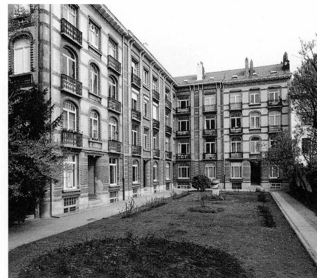
De Sans-Souciquare wordt gevormd door een opmerkelijk geheel woningen opgetrokken rond een groen punt.
