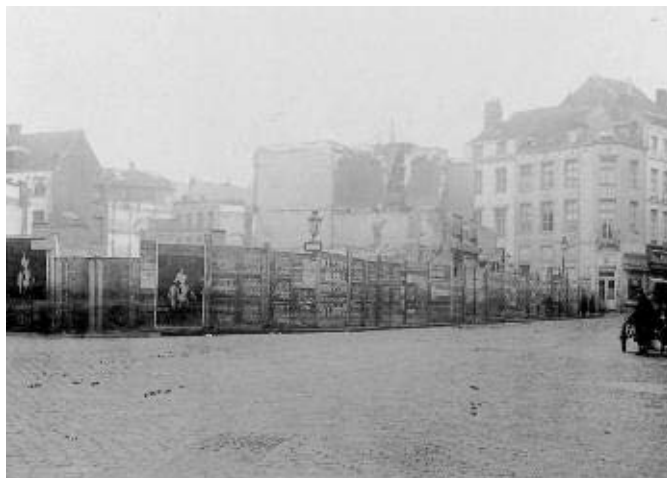
De werken aan de Noord-Zuidverbinding gezien vanaf de Grasmarkt in 1911. Een aanzienlijk verminkte en overdrukke handelswijk.
