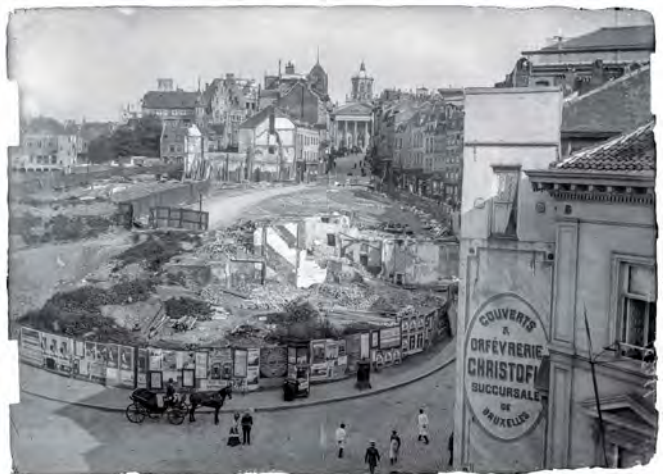
De Sint-Rochuswijk na de gedeeltelijke sloop, foto uit 1905. Op deze kaalslag werd de Vacherottuin aangelegd, en vervolgens de huidige Kunstberg. © KIK-IRPA, Brussel, a103011
