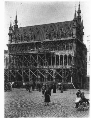
Het Broodhuis tijdens de heropbouw. Het bovenste gedeelte van de toren ontbreekt nog.
