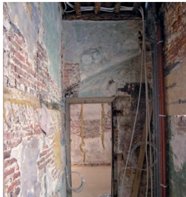
Afb. 22 Dienstgang met de schoorsteen die de ruimte overspant (P. Sosnowska © KMKG-MBHG).
