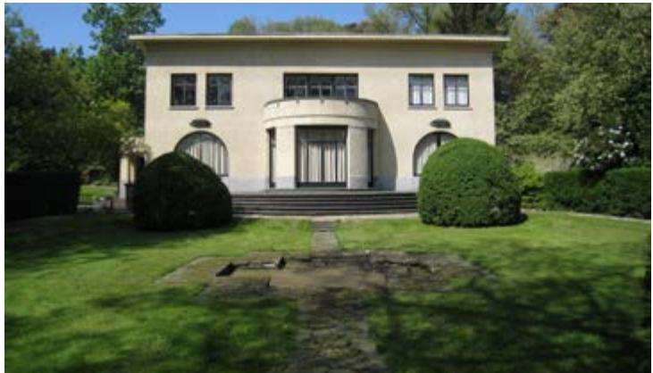
AFB. 6 Villa Gosset en tuin met bassin op de voorgrond, Horizonlaan, Sint-Pieters-Woluwe (E. Stoller © urban.brussels).
