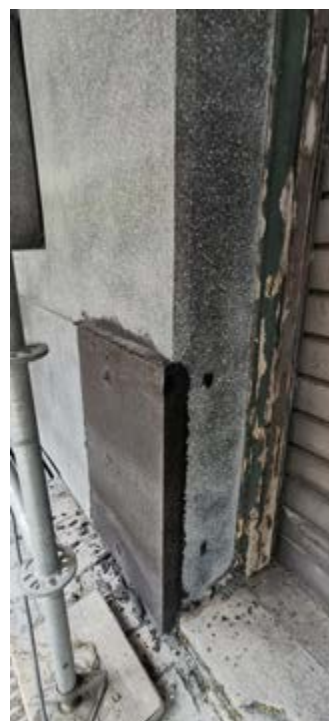
AFB. 3B Sokkel in gepolijst granito, identieke restauratie (M. Core © urban.brussels).
