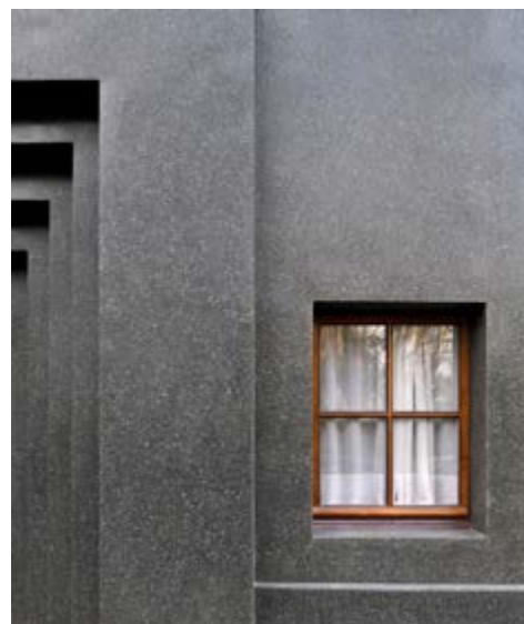
AFB. 3C Sokkel in gepolijst granito en schrijnwerk, na de restauratie (© G. de Kinder, 2024).
