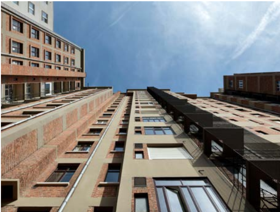
AFB. 4B Gevel aan de koer, na de restauratie (© G. de Kinder, 2023).
