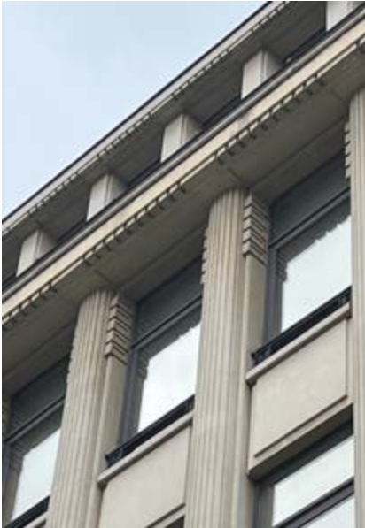
AFB. 9A Antoine Courtens, Electrorail, Verenigingstraat 57-61 in Brussel, 1930. Detail van de gevel (Foto van de auteur).
