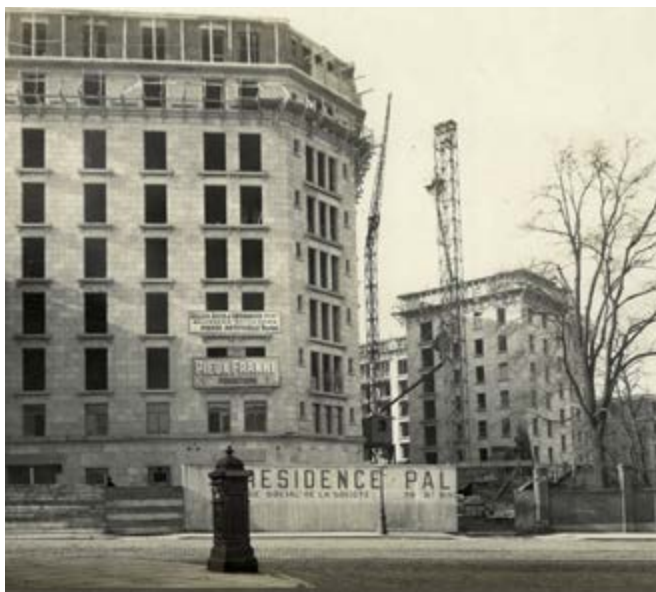
AFB. 4 Werk in uitvoering gezien vanaf de Wetstraat. 4 april 1925 (© privécollectie).
