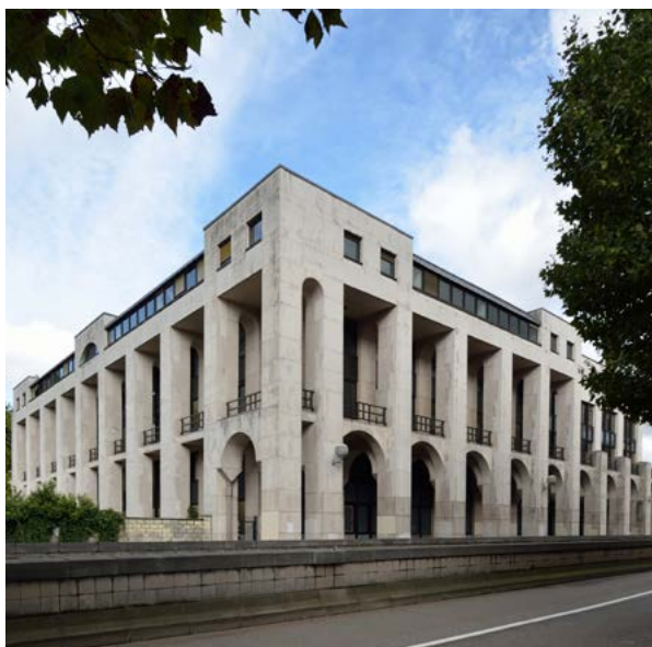
AFB. 1 Notelaarstraat 211, Brussel. Gebouw in zijn oorspronkelijke staat, 2019 (W. Kenis © urban.brussels).
