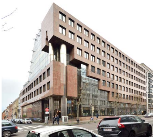
AFB. 1 Kortenberglaan nr. 150, Brussel. Gebouw in zijn oorspronkelijke staat, 2019 (W. Kenis © urban.brussel).
