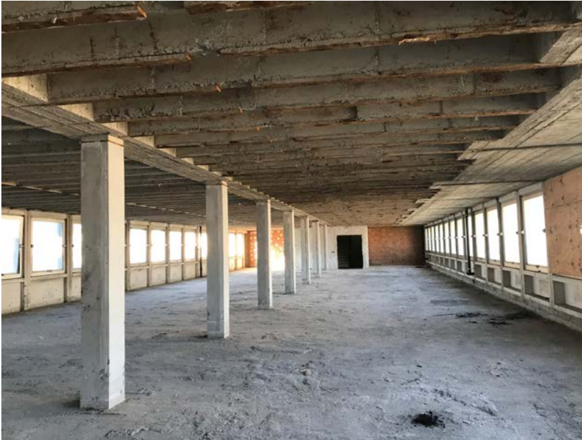
AFB. 3 Skelet in gewapend beton en openplanstructuur (© D. Stiennon).
