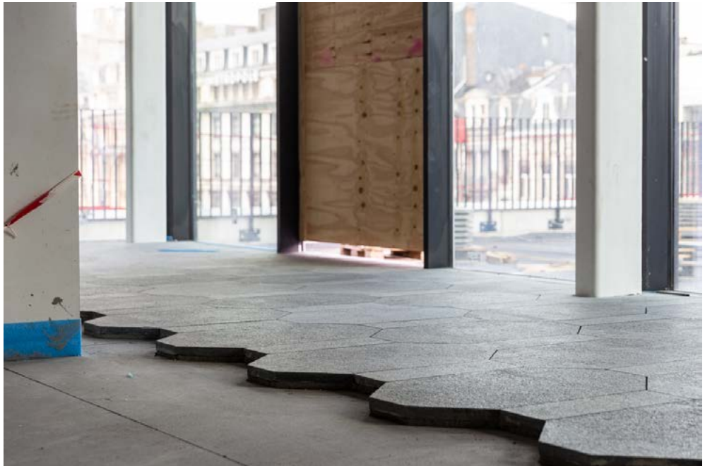
AFB. 4 Multi, recuperatie vloertegels (Courtesy of CONIX RDBM Architects © Jasper Van der Linden).
