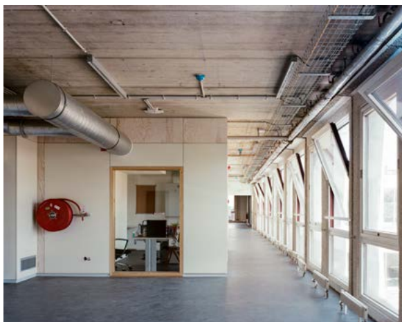
AFB. 3 ESP Karreveld, interieur, zichtbare leidingen en structurele element, nieuwe scheidingswanden uit gerecupereerde materialen en multiplex platen (© Séverin Malaud).
