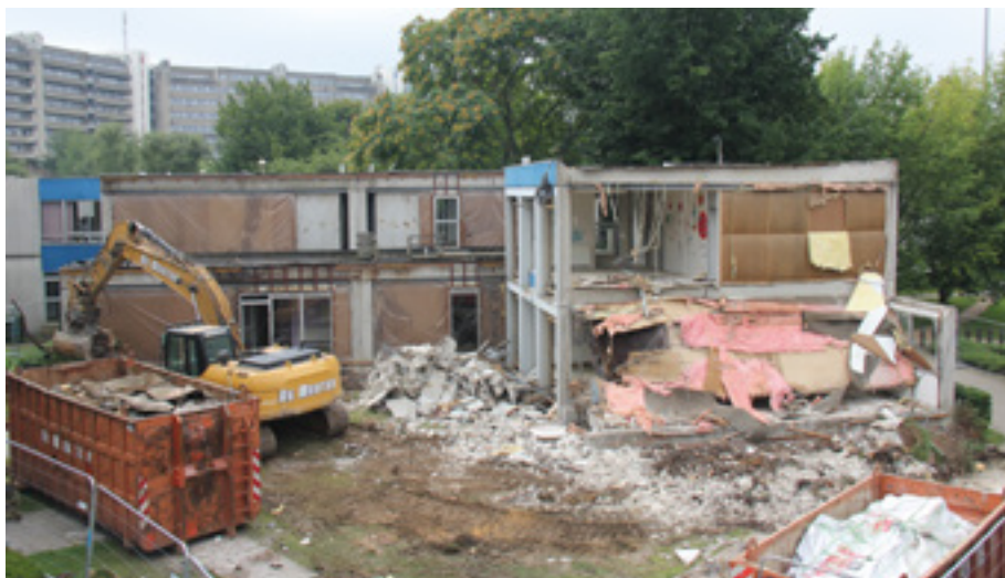
AFB. 6 In 2016 werden enkele modules afgebroken, om plaats te maken voor de uitbreiding van het VUB-zwembad (© VUB Architectural Engineering, 2016).
