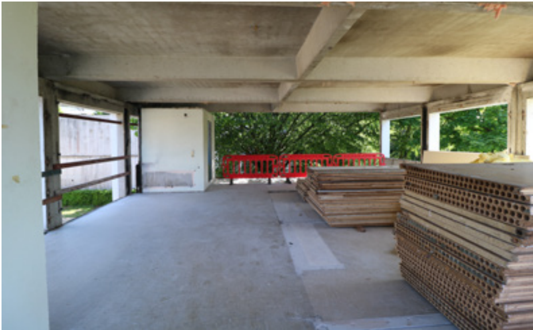
AFB. 21 De binnenwanden van de studentenwoningen bestaan uit Fontexpanelen in geperst hout, 5 cm dik en met interne, holle verticale kanalen (© Fontex, s.d.).
