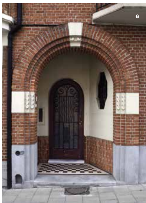
AFB. 6 Augustijnnonnenstraat 106, Jette, binnenliggend portiek (© ARCHistory, foto 2020).
