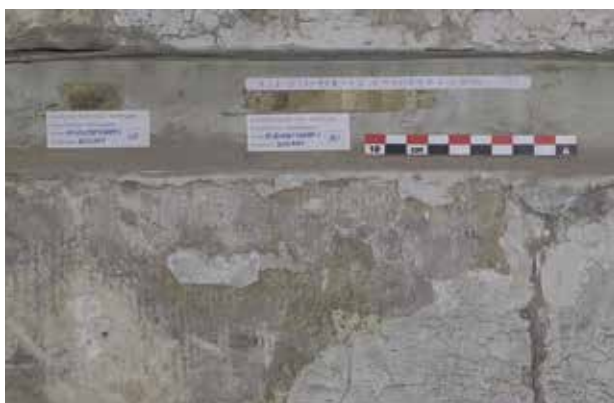
AFB. 15 Stratigrafie en punctie van de bossage op de gevel van de Anjelierentraat 3. Onder de verflagen zijn sporen van steenhouwen zichtbaar, Kleurhistorisch onderzoek Fenikx bv, 2019-2020 (© Fenikx bv, foto Ann Verdonck).
