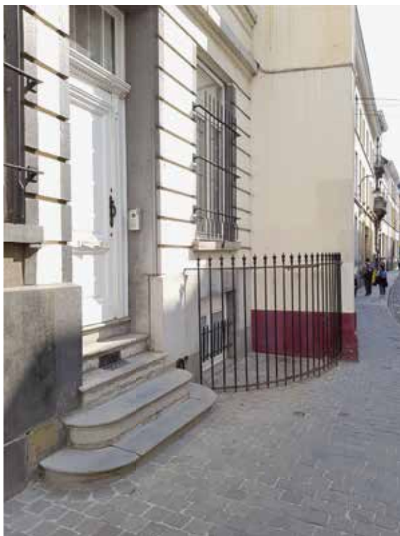
Afb. 3 In de straat Nieuwland wordt een gevelverspringing beschermd door een halfronde hek. De vrijgekomen ruimte door de nieuwe rooilijn van het linkerperceel bood plaats voor een uitstekend bordes, dat nochtans in theorie verboden was door het bouwreglement. (Foto van de auteur, 2018).
