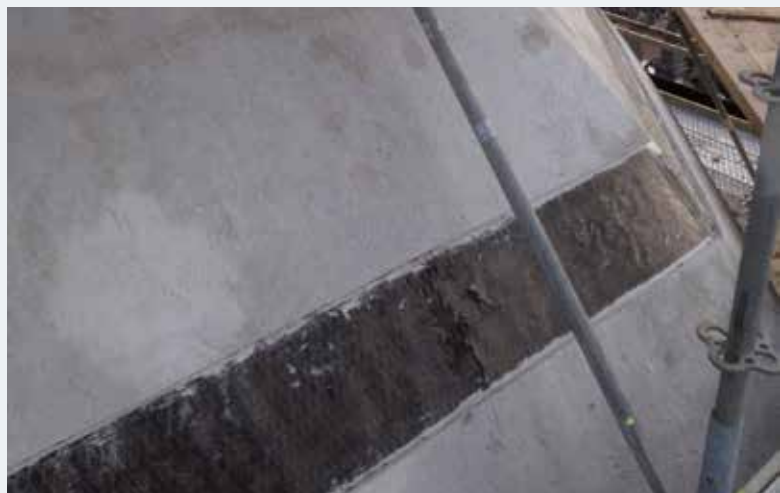
Afb. 20 Band met koolstofvezels gelijmd op het buitenwelfvlak (2015 © Origin).
