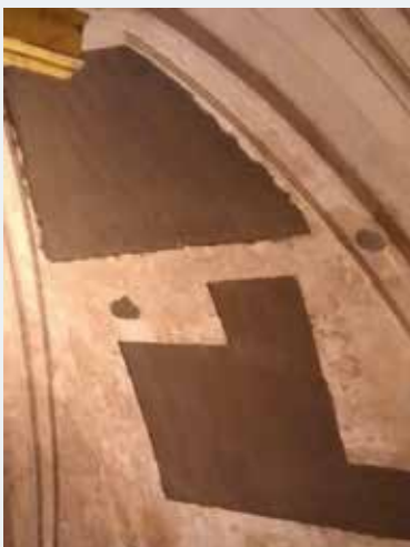
Afb. 19 Lokale herstellingen aan het binnenwelfvlak (2015 © Origin).
