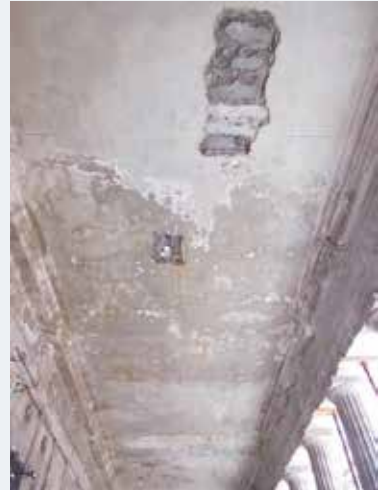
Afb. 15 Overdekking van een galerij, begin van de werken (2015 © Origin).
