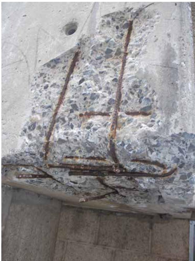
Afb. 3 Gedecapeerd beton voor reparatie (2017 © Origin).
