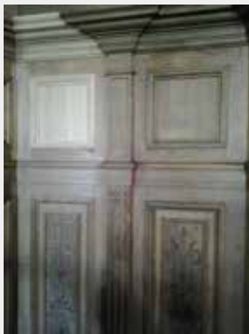
Afb.8b Restauratie van elementen van de houten lambriering (E. de Sart, 2014 © urban.brussels).
