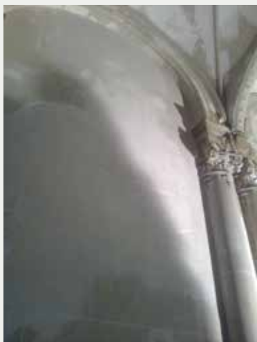
Afb.9a Toestand van similisteen bij start van de werken (E. de Sart, 2013 © urban.brussels).
