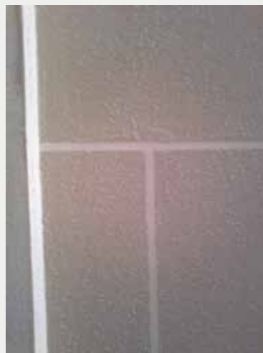
Afb.9c De finale afwerking in similisteen (E. de Sart, 2014 © urban.brussels).
