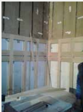
Afb.8c Reconstructie van de houten lambrieringen (E. de Sart, 2014 © urban.brussels).
