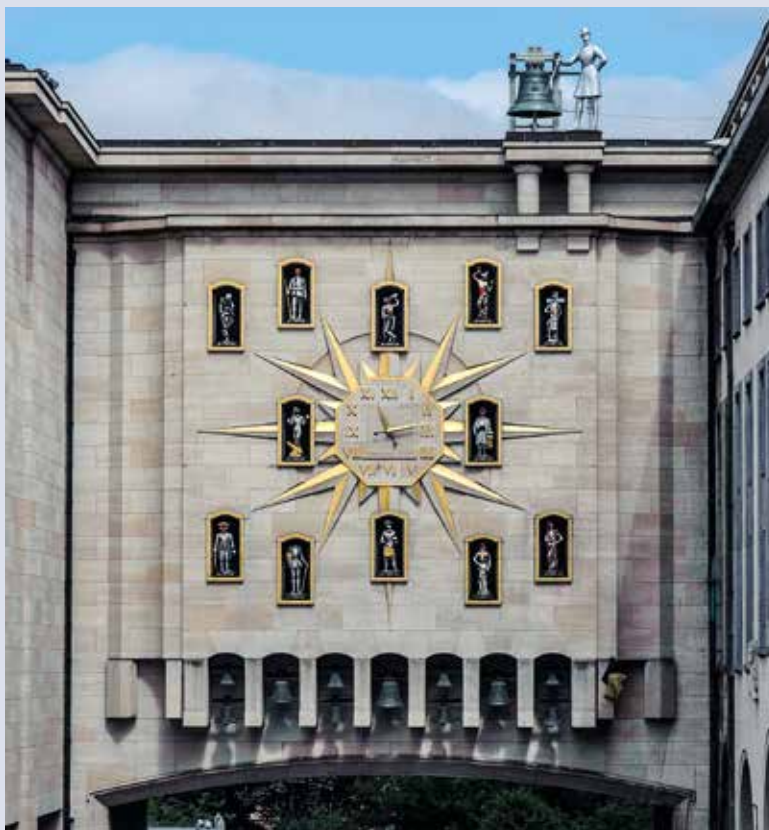
Afb.2 De beiaard van de Kunstberg aan de achtergevel van het Dynastiepaleis, boven de boogvormige doorgang, ingehuldigd in 1965 (A. de Ville de Goyet, 2018 © BUP/BSE).
