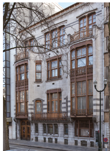
Afb. 1 De voorgevel van het Hotel Solvay in 2017 (© KIK-IRPA_GOB).
