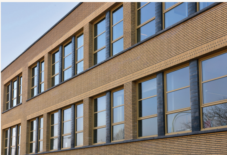
Afb. 4 Gevel en schrijnwerk na restauratie (© Roose Partners architects).
