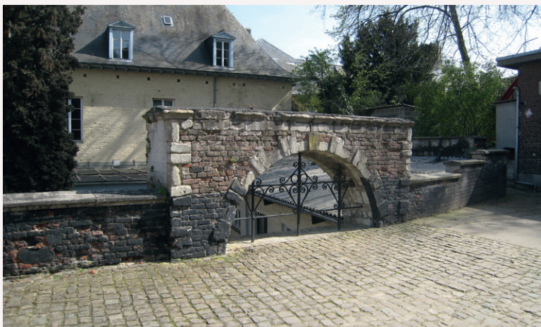
Afb. 2 De dichtgemetselde poort gezien vanuit het westen (foto van de auteur, KMKG, 2014 © GOB).
