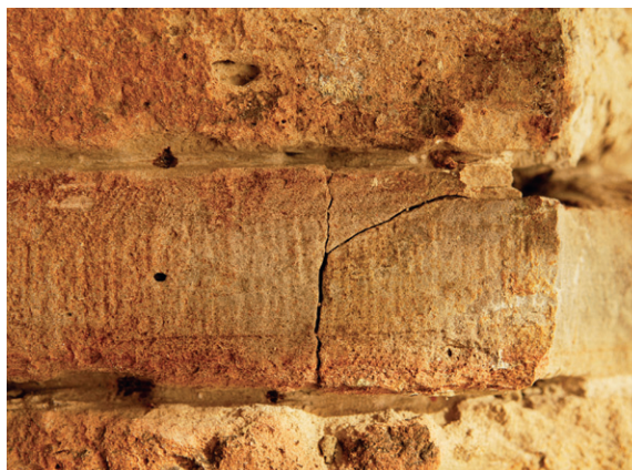
Afb. 17 Zuidelijke vleugel van het klooster van de Ter Kamerenabdij in Elsenne, houwtechniek van het type la te dateren vóór 1420 (foto van de auteur, 2014 © GOB).
