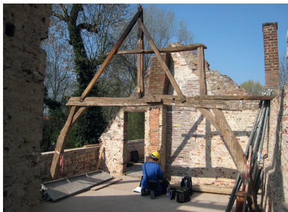
Afb. 16 Nekkersgatmolen in Ukkel: kapspant (foto van de auteur, 2011 © GOB).
