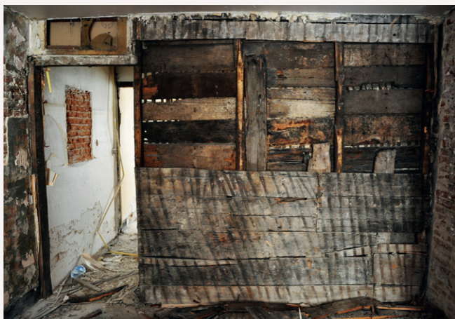
Houten tussenwand in het trappenhuis Steenstraat 34 in Brussel (P. Gautier, KMKG, 2010 © GOB).
