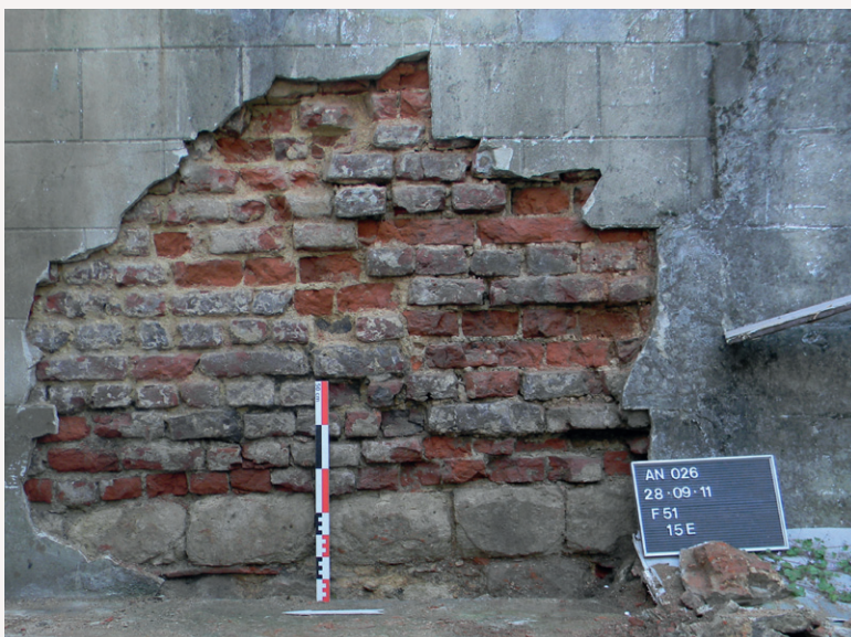
Stenen plint in de woning gelegen Zonnebloemenstraat 15E in Anderlecht (V. Moulaert, RPAW, 2011 © GOB).
