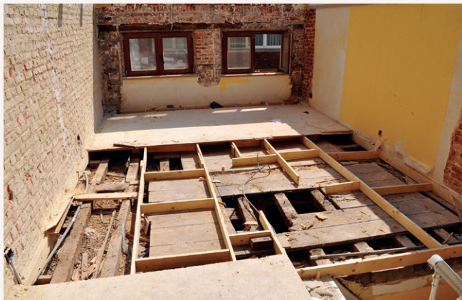
Plankieren tijdens het vrijleggen, Steenstraat 34 in Brussel (P. Gautier, KMKG, 2010 © GOB).
