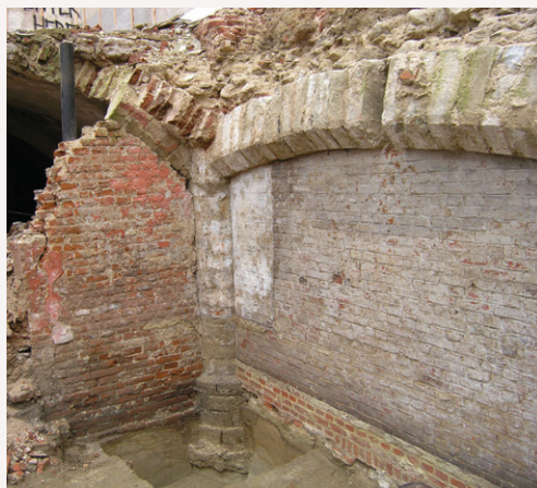
Kolom en gordelbogen in witte steen die een bakstenen gewelf ondersteunen (B. Claes, KMKMG, 2010 © GOB).
