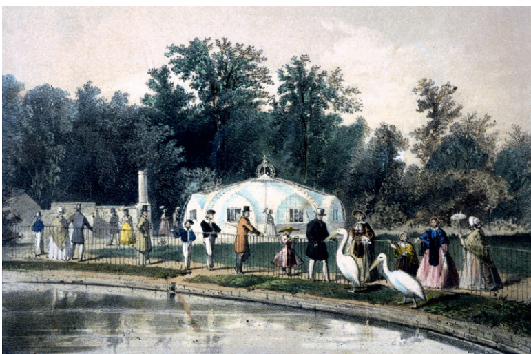
Afb. 5 Zicht op de serres van de dierentuin, waaronder de serre Victoria Regia. Steendruk van A. Canelle, 1856. (© SAB)
