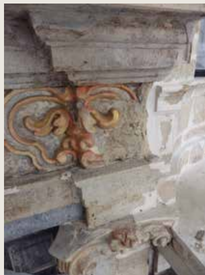
De Vos. Verpulvering van een fries in oorspronkelijke steen (Avendersteen?) (© CHE, 2012).
