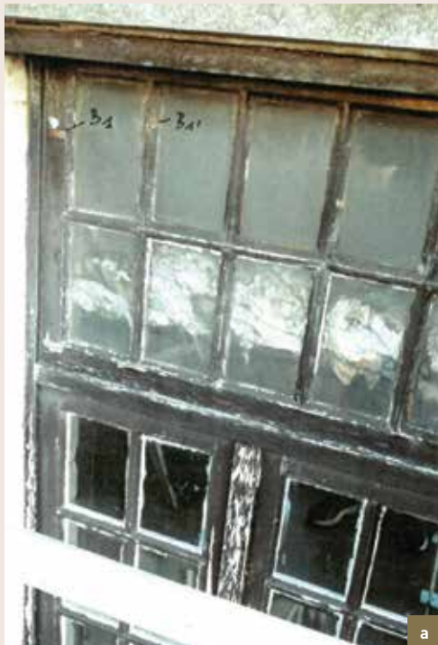
Den Ezel . a, b en c) stratigrafisch onderzoek en macrofotografie van een raamkozijn waaruit blijkt dat de oorspronkelijke laag een vernis was (a en b © M. Decroly, 2002 ; c) © KIK-IRPA, 2002).
