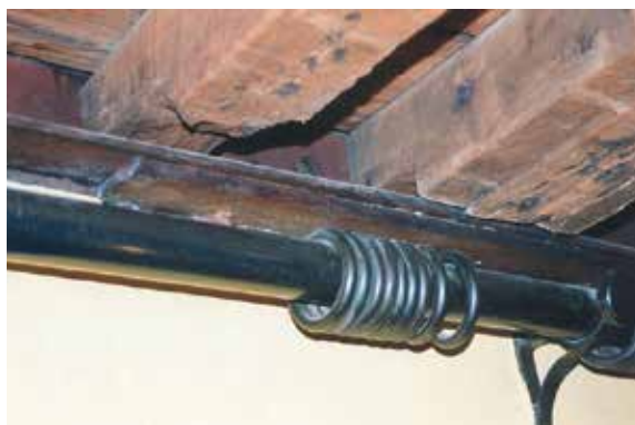
Den Engel, hoekijzer ter ondersteuning van de oude balklagen (© CHE, 1999).
