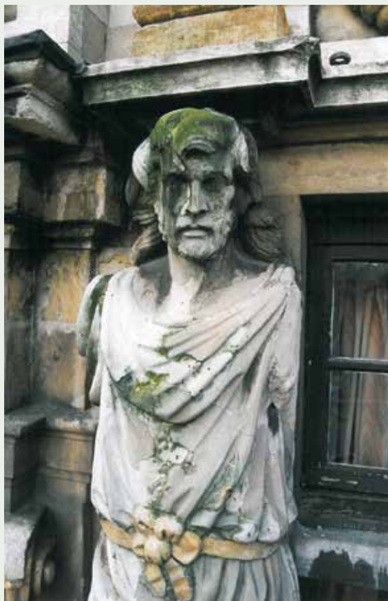
Den Sack . Een van de hermen. Oude reparaties zijn zichtbaar en het beeld is bedekt met mossen [© CHE, 2000].
