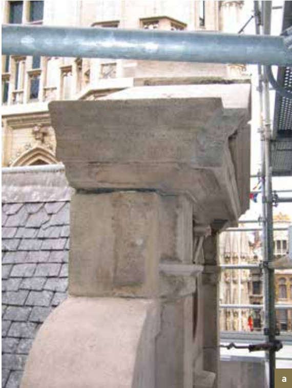
De Sterre . Structurele problemen. a) overhelling van het fronton van de geveltop aan de kant van de Grote Markt. Euvillesteen; b) verplaatsing van stenen in de achtergevel. Scheurmeter geplaatst bij het opmaken van de bevindingsstaat (© CHE, 2008).
