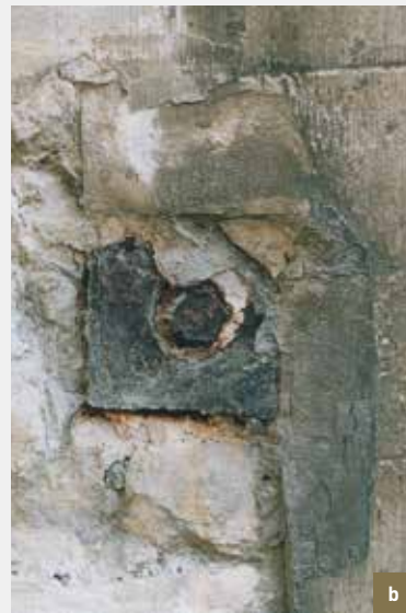
Den Ezel . Metalen ankers. a) lokalisering van de ankers door middel van een metaaldetector; b) vierkante plaat zichtbaar in de gevel door de afbrokkeling van het parement; c) weghalen van het binnenpleisterwerk om de vorm van het anker te achterhalen; d) detail van de loden verzegeling in de steen; e) metallografische analyse. Micrografie (a, b, c en d) : © CHE, 2001; e) : © VUB, 2001.
