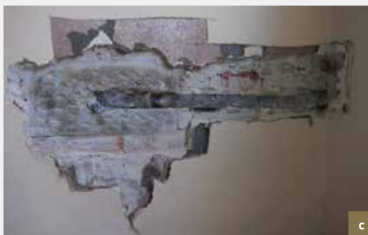
Den Ezel . Metalen ankers. a) lokalisering van de ankers door middel van een metaaldetector; b) vierkante plaat zichtbaar in de gevel door de afbrokkeling van het parement; c) weghalen van het binnenpleisterwerk om de vorm van het anker te achterhalen; d) detail van de loden verzegeling in de steen; e) metallografische analyse. Micrografie (a, b, c en d) : © CHE, 2001; e) : © VUB, 2001.
