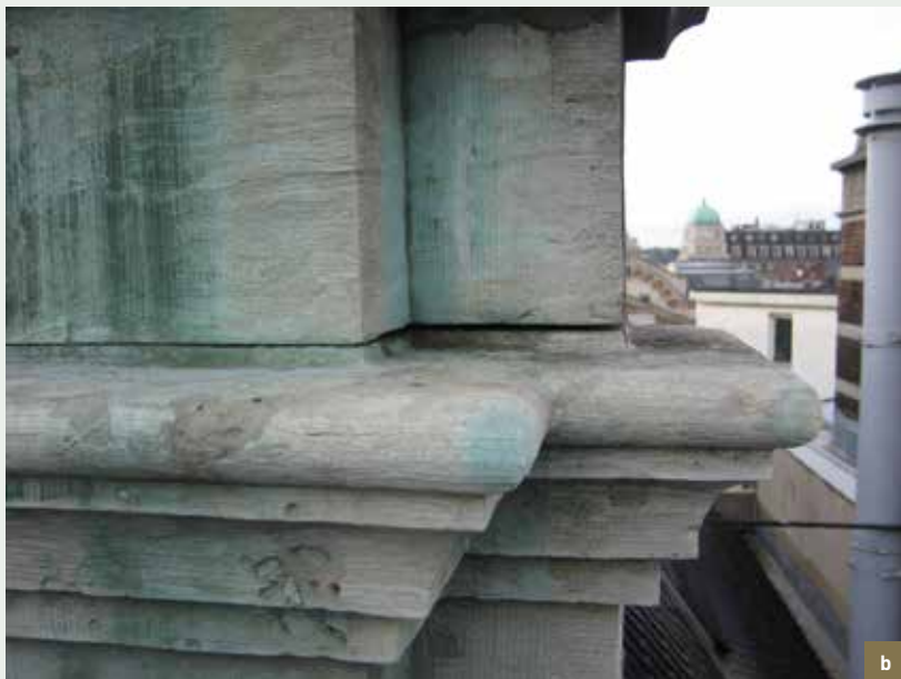
Den Cruywagen. Bovenste gedeelte van de gevel. Groene druipsoren ten gevolge van de oxydatie van de koperen decoraties. a) totaalbeeld; b) detail van druipsoren op Gobertangestein (© CHE, 2014).
