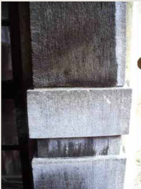
Den Ezel. Detail van een pilaster met bossage in geciseleerde hardsteen (© CHE, 2000).
