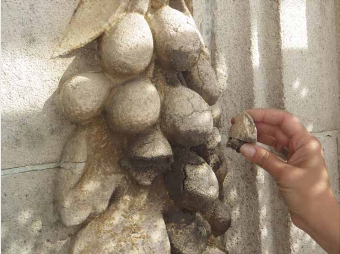
Den Cruywagen. Fruitguirlande. Een afgebroken ornament. Euvillesteen (© CHE, 2014).
