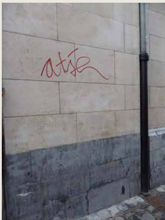
Den Coninck Van Spaignien. Steenkanker ten gevolge van de aanwezigheid van stylolieten en haaks op de steenbedding geplaatste balusters. Hardsteen (© CHE, 2014).
