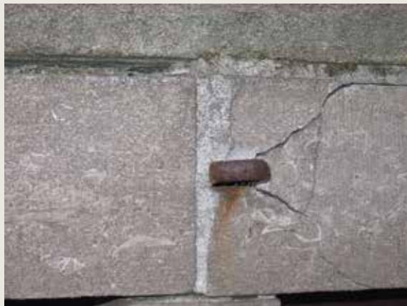
De Heert. Barsten in een hardstenen element, ten gevolge van het roesten van de metalen ring (© CHE, 2000).
