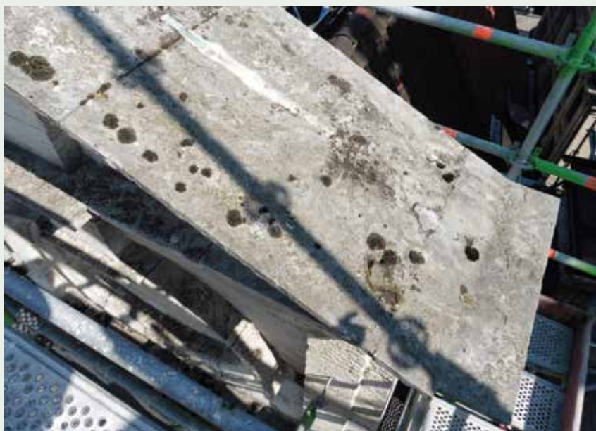
Den Helm . Mosontwikkeling op de helling van een fronton. Gobertangestein [© CHE, 2015].
