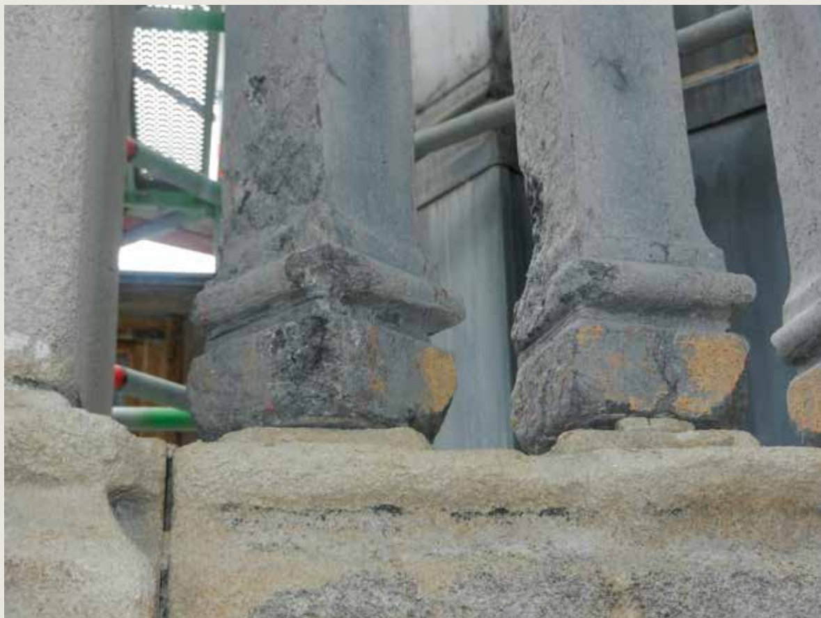
Den Coninck Van Spaignien. Steenkanker ten gevolge van de aanwezigheid van stylolieten en haaks op de steenbedding geplaatste balusters. Hardsteen (© CHE, 2014).
