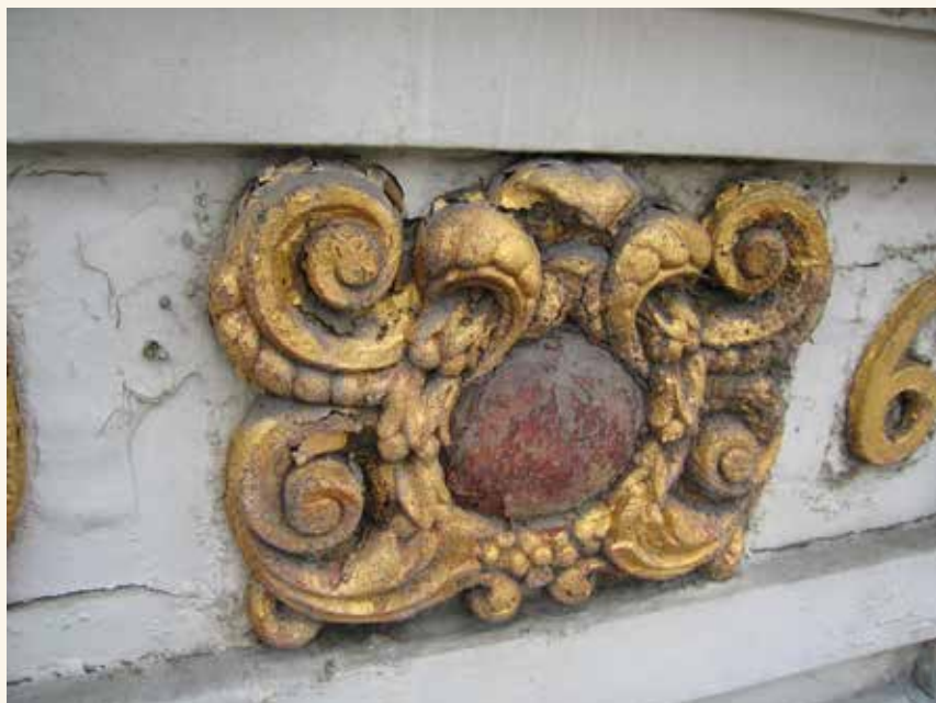
Het Vosken en Den Eycke. Medaillons met blazen in de verf, afschilferend verguldsel en algemene verontreiniging (© CHE, 2014).
