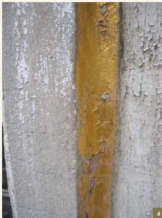
De Gulden Boot. a) detail van het fronton. Afschilferende verf en verguldsel; b) een engel. Verontreinigde verf. Verguldsel bijna verdwenen; c) detail van de inscripties op het timpaan. Gebarsten bepleistering. Verf verdwenen. Verguldsel aangetast; d) detail van een pilastersokkel met afbladderende verf en verguldsel (© CHE, 2012).
