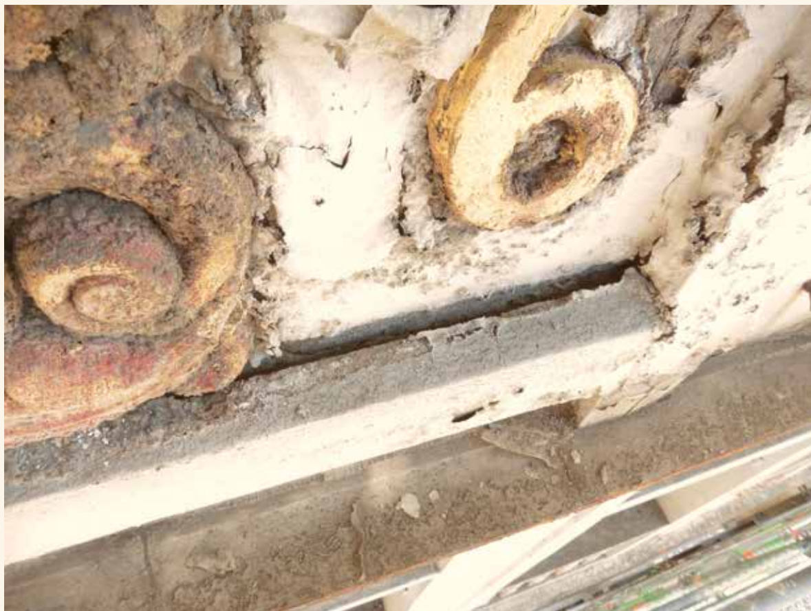
Het Vosken en Den Eycke. Medaillons met blazen in de verf, afschilferend verguldsel en algemene verontreiniging (© CHE, 2014).
