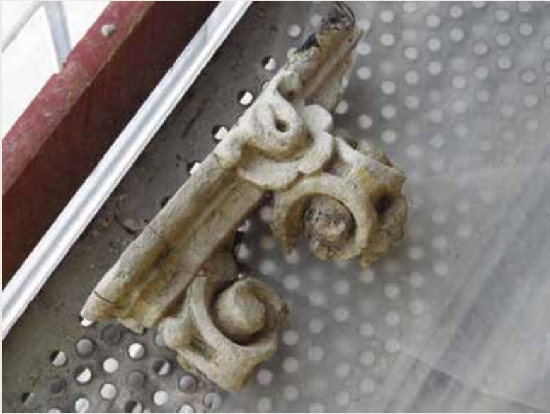
Den Sack. Een afgebroken kapiteel (© CHE, 2014).
