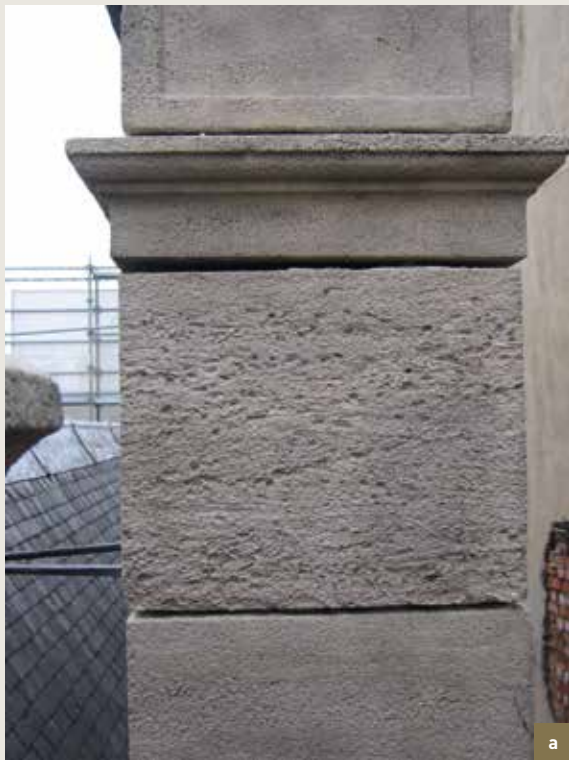
De Sterre. a en b) verplaatsing en openstaande voegen in de Euvillesteen ten gevolge van structurele problemen (drukkracht van gecorrodeerde metalen vloerelementen) (© CHE, 2008).
