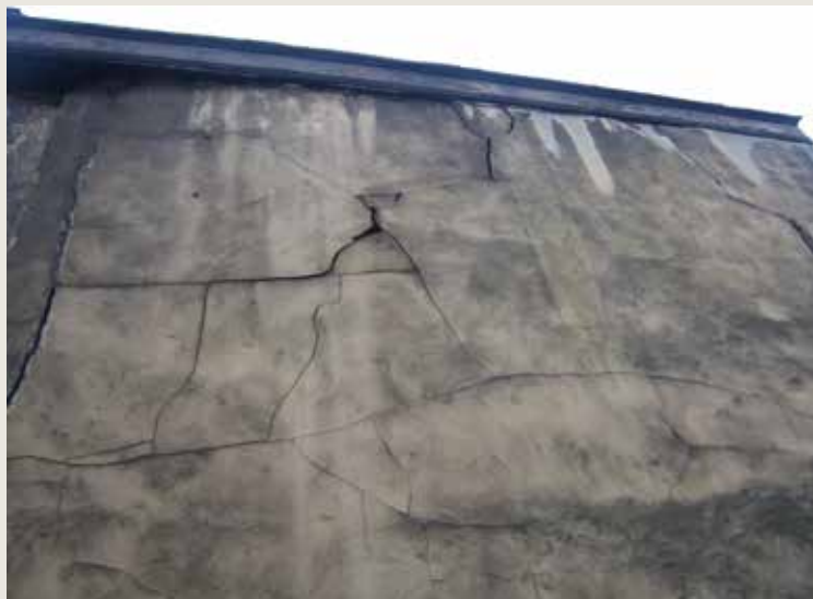
De Swane. Loskomen van de bepleistering van de rechtse mandelige muur (© CHE, 2008).
