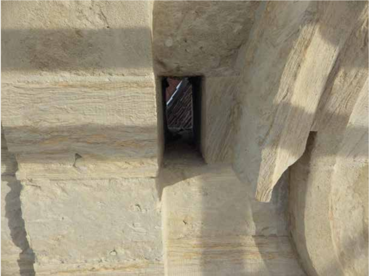
Den Helm. Detail van een geveltop in Gobertangesteent waarin de voor deze steen typische bioturbaties zichtbaar zijn (© CHE, 2015).
