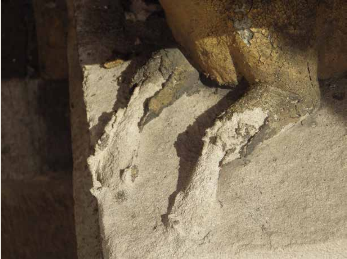
De Wolvin. Verpulvering van de Euvillesteen van een beeldhouwd element (© CHE, 2014).
