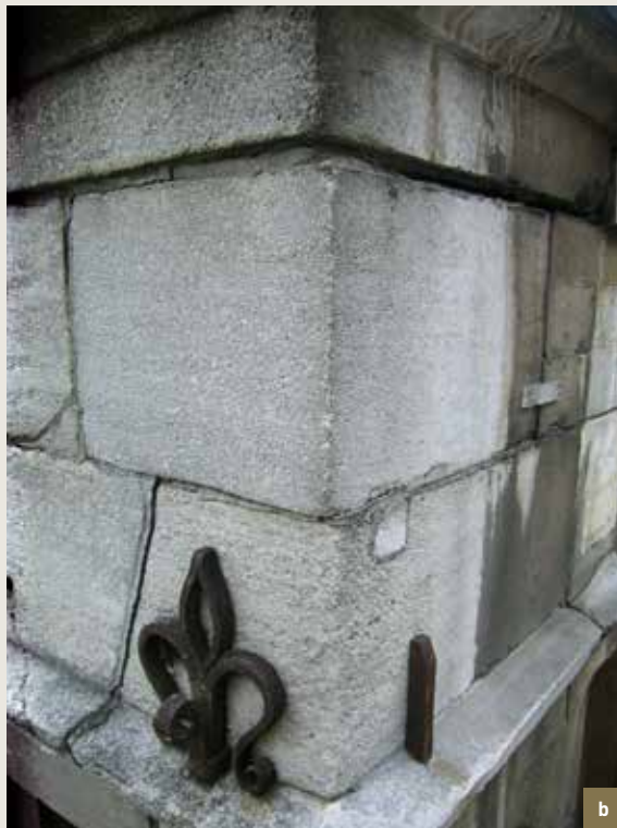
De Sterre. a en b) verplaatsing en openstaande voegen in de Euvillesteen ten gevolge van structurele problemen (drukkracht van gecorrodeerde metalen vloerelementen) (© CHE, 2008).
