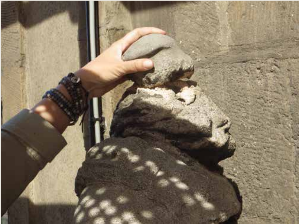
De Wolvin. Verpulvering van de Euvillesteen van een beeldhouwd element (© CHE, 2014).
