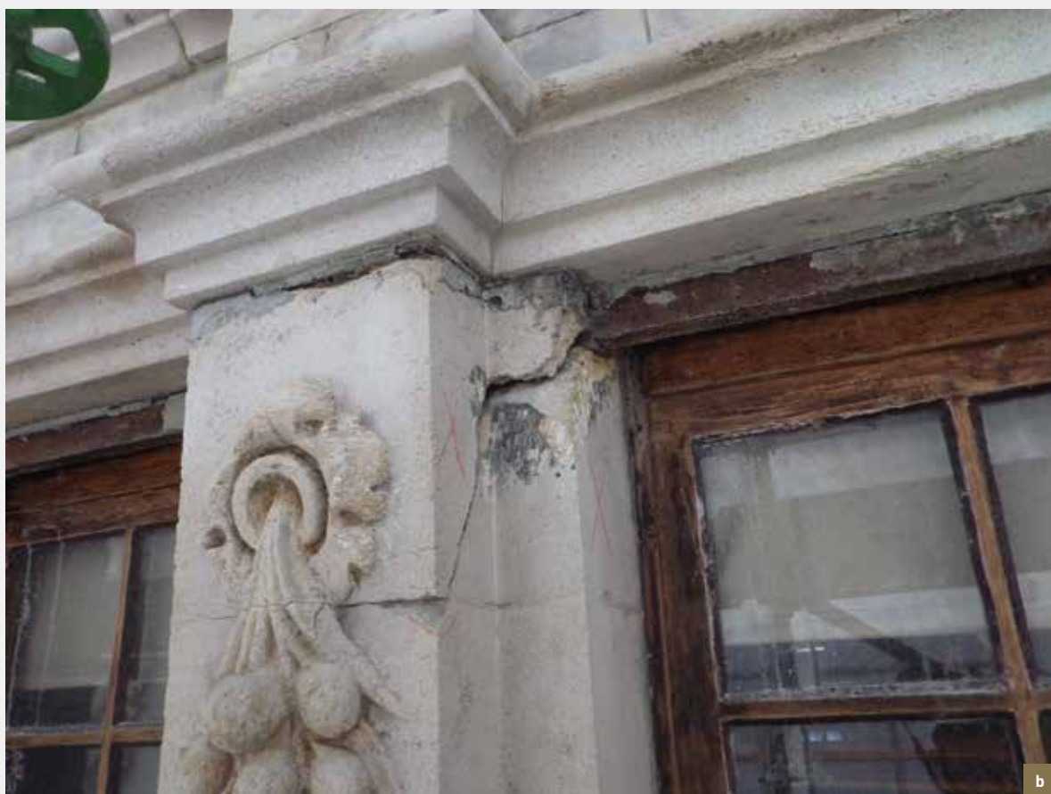
Den Cruywagen. Vierkante metalen staven ter versterking van de lateien. Hun corrosie veroorzaakte barsten in de stenen. a) barsten in elementen in arduin en Balegemse steen. Foto's genomen tijdens de werf; b) barst in een element in Euvillesteen (© CHE, 2014).
