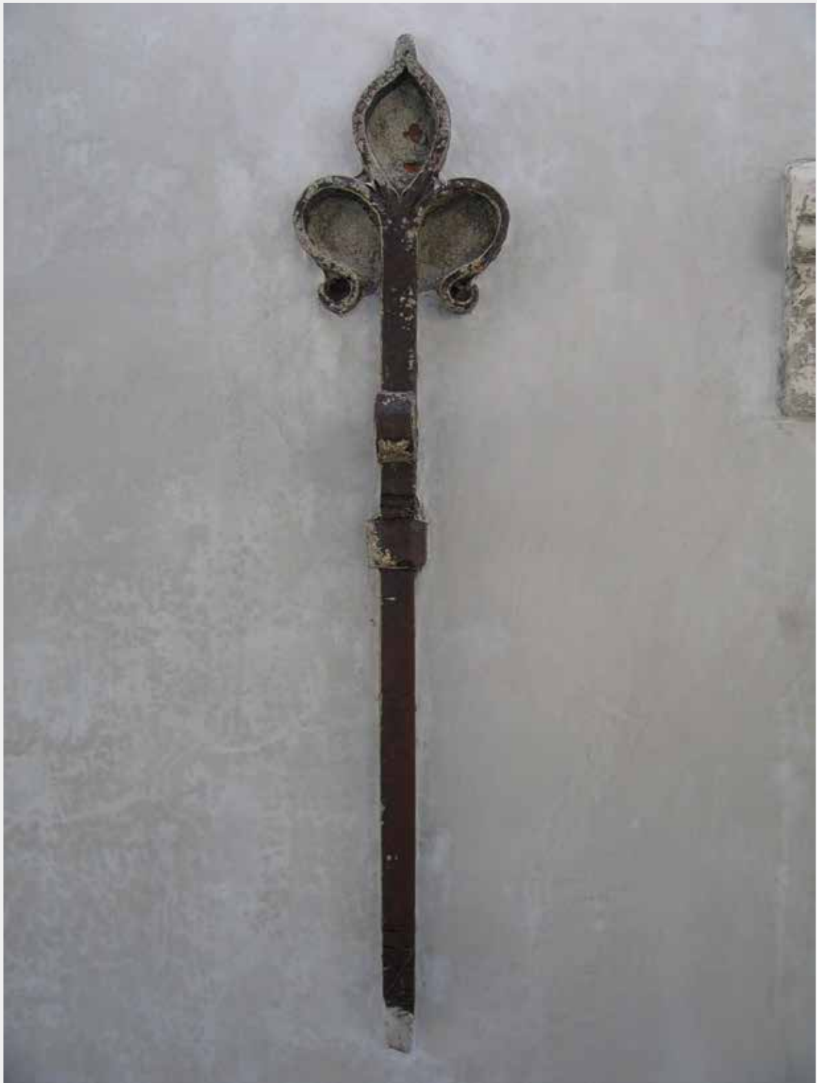
Den Bergh Thabor . Bepleisterde zijgevel. Metalen anker (© CHE, 2008).
