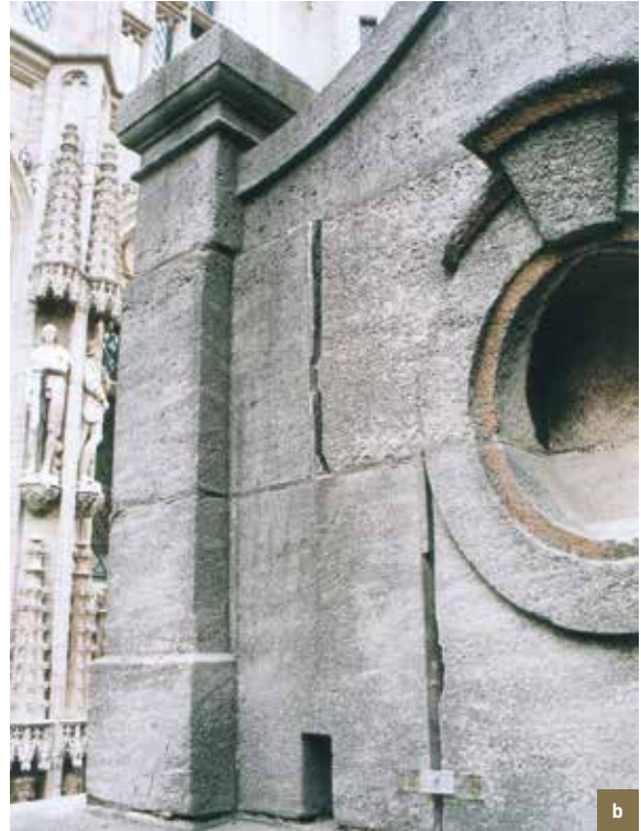
De Sterre . Structurele problemen. a) overhelling van het fronton van de geveltop aan de kant van de Grote Markt. Euvillesteen; b) verplaatsing van stenen in de achtergevel. Scheurmeter geplaatst bij het opmaken van de bevindingsstaat (© CHE, 2008).
