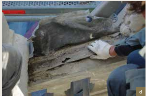
De Gulden Boot. a) linkervleugelstuk met bloemmotief. Het element komt los en dreigt naar beneden te glijden ten gevolge van corrosie van een metalen anker; b) idem. Rechtergedeelte. Plaatsing van een tijdelijk beschermingsnet na inspectie en in afwachting van de restauratie; c) overhelling van de rechterpinakel van de topgevel; d) idem linkerkant. Onder het lood werd roestvorming van het metalen anker vastgesteld dat deze problemen veroorzaakt. (© CHE, 2000).
