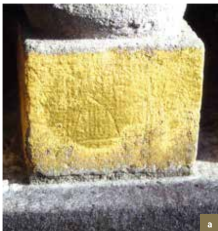
Steenmerken. a) Den Ezel. Steenmerk op een vierkant blok hardsteen; b) Den Cruywagen. Genummerde stenen. Balegemse steen; c) Het Brouwershuis. Steenmerk op de achterkant van een in hardsteen gesculpteerde dolfijn (© CHE, 2002 en 2014).
