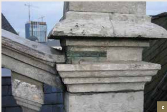
De Gulden Boot. a) linkervleugelstuk met bloemmotief. Het element komt los en dreigt naar beneden te glijden ten gevolge van corrosie van een metalen anker; b) idem. Rechtergedeelte. Plaatsing van een tijdelijk beschermingsnet na inspectie en in afwachting van de restauratie; c) overhelling van de rechterpinakel van de topgevel; d) idem linkerkant. Onder het lood werd roestvorming van het metalen anker vastgesteld dat deze problemen veroorzaakt. (© CHE, 2000).
