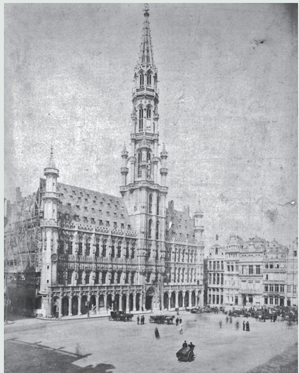
Afb. 3 Zicht op het Brusselse stadhuis in 1893 tijdens de werken voor de heropbouw van de topgevel in de huidige Karel Bulstraat (© SAB).
