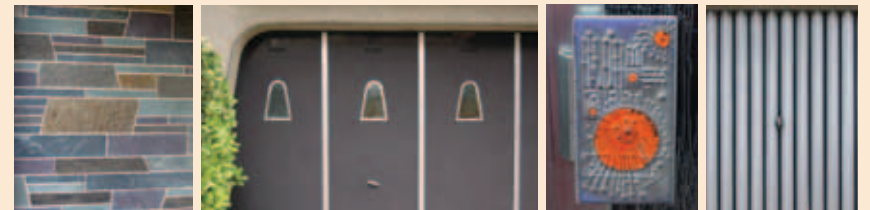
Van links naar rechts: Maria Van Hongarijelaan 5, Villegaslaan 17, Stedenbouwlaan 66, Villegaslaan 25.
