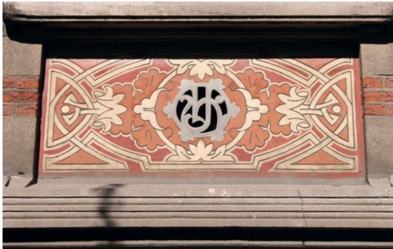
Fig. 16 Bouche d'aération intégrée dans le décor d'un sgraffite (© M. Wal).
