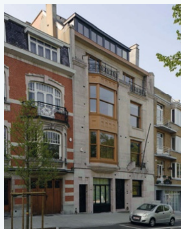
Fig. 2 Avenue Besme 107-109 à Forest. Logements et bureaux. Bâtiment de style Art Déco dont la performance est basse énergie. Les châssis de façade avant ont été conservés et rénovés avec remplacement du simple vitrage par du double vitrage 1.1 (A. de Ville de Goyet, 2015 © SPRB).
