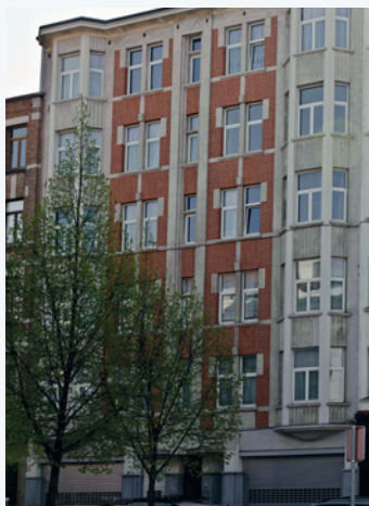
Fig. 4 Rue du Comte de Flandre 45-51 à Molenbeek-Saint-Jean. Ateliers Mommaerts, façade avant classée. Celle-ci n'a pas été isolée par l'intérieur, mais on arrive toutefois à une solution basse énergie (A. de Ville de Goyet, 2015 © SPRB).
