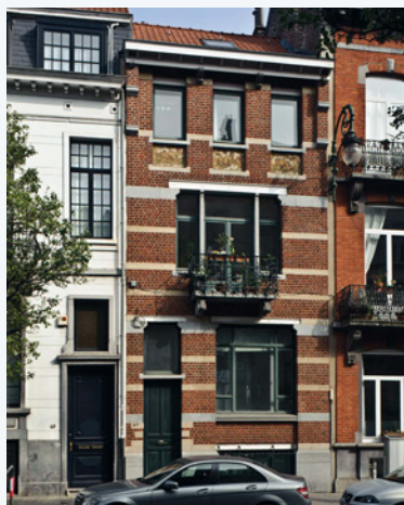
Fig. 3 Avenue Ducpétiaux 47 à Saint-Gilles. Maison individuelle, rénovée en basse énergie. La façade a été maintenue. Elle est isolée par l'intérieur sur les parties intérieures non classées, cela concerne trois des quatre étages. Les propriétaires ont opté pour la pose d'une deuxième fenêtre en retrait de la première afin de conserver la situation initiale (A. de Ville de Goyet, 2015 © SPRB).
