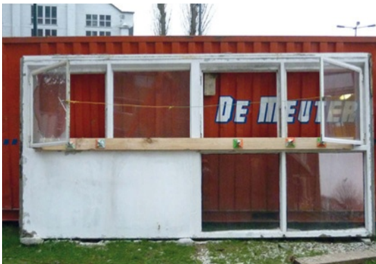
Afb. 15 Bestaande situatie (© Origin).
