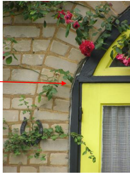
Foto P5040063 van het huis nr. 4 aan de Tuberozentraat, waarbij de zijkanten van de bakstenen cirkelboog aangepast zijn aan het bestaande schrijnwerk.
