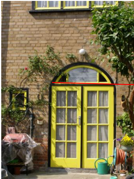
Foto P5040063 van het huis nr. 4 aan de Tuberozentraat, waarbij de zijkanten van de bakstenen cirkelboog aangepast zijn aan het bestaande schrijnwerk.
