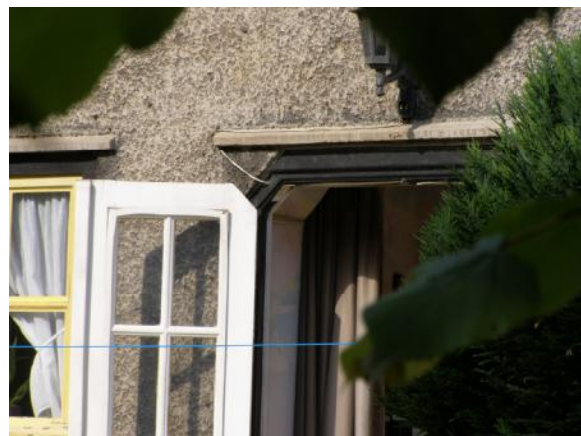
Plan Le Logis nr. 26: Zijgevel van huistype H&H1, J.J. Eggericx, (1922) en Foto P5040026 van het huis nr. 6 aan de Cyclamenstraat. Hier sluit de druiprand onmiddellijk aan op het portaal.
