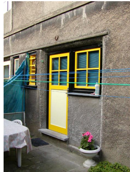
Foto P5040078 en P070100 van de dubbelwoningen aan de Salviastraat 19-21 en 3-5. Het portaal en het terras hebben beide afgeschuinde boven- en zijkanten, maar een druiprand bevindt zich enkel bij de portalen.
