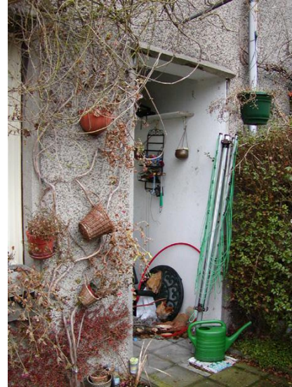
Plan Le Logis nr. 200-8: Achtergevel van huistype D1 van de uitbreiding van Le Logis-"Le Plateau" en foto PC170151 van het huis nr. 27 aan de Nimfenlaan, waarbij de originele portaalopening met druiprand nog aanwezig is.
