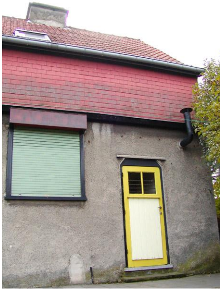
Foto's PA170135 en PA170089 van de huizen nr. 6 en 24 aan de Boterbloemenstraat. Deze huizen van type R voldoen aan het type 1 van de portalen, nl. ze hebben de typische afgeschuinde bovenhoeken.
