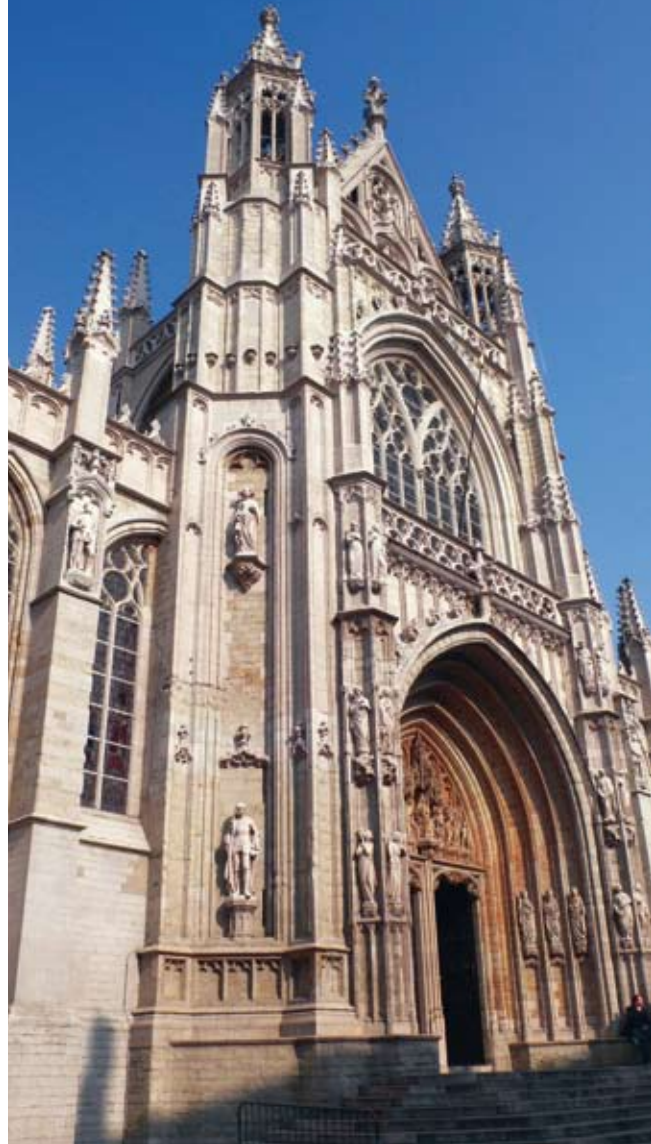
Église Notre-Dame du Sablon à Bruxelles (XV e siècle) : interventions des architectes Jules Van Ysendijck et Maurice Van Ysendijck en 1896-1899 (photo de l'auteur).
