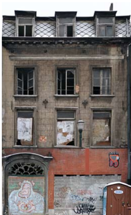
Quai au Bois de Construction n° 3, façade principale (photo de l'auteur © MRBC-DMS).
