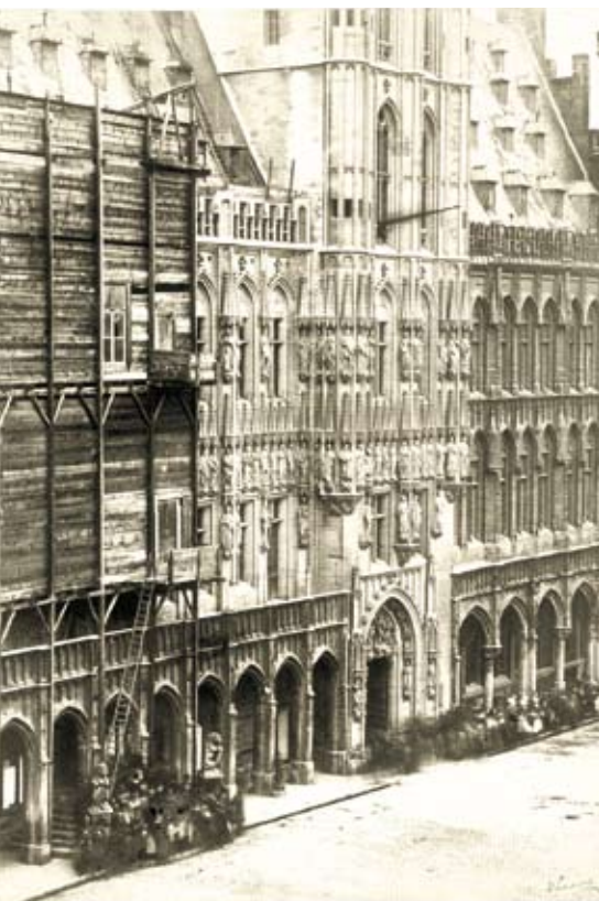
Détail de l'Hôtel de Ville de Bruxelles pendant la restauration, avec échafaudage en façade (photo E. Fierlants, coll. Maison du Roi).
