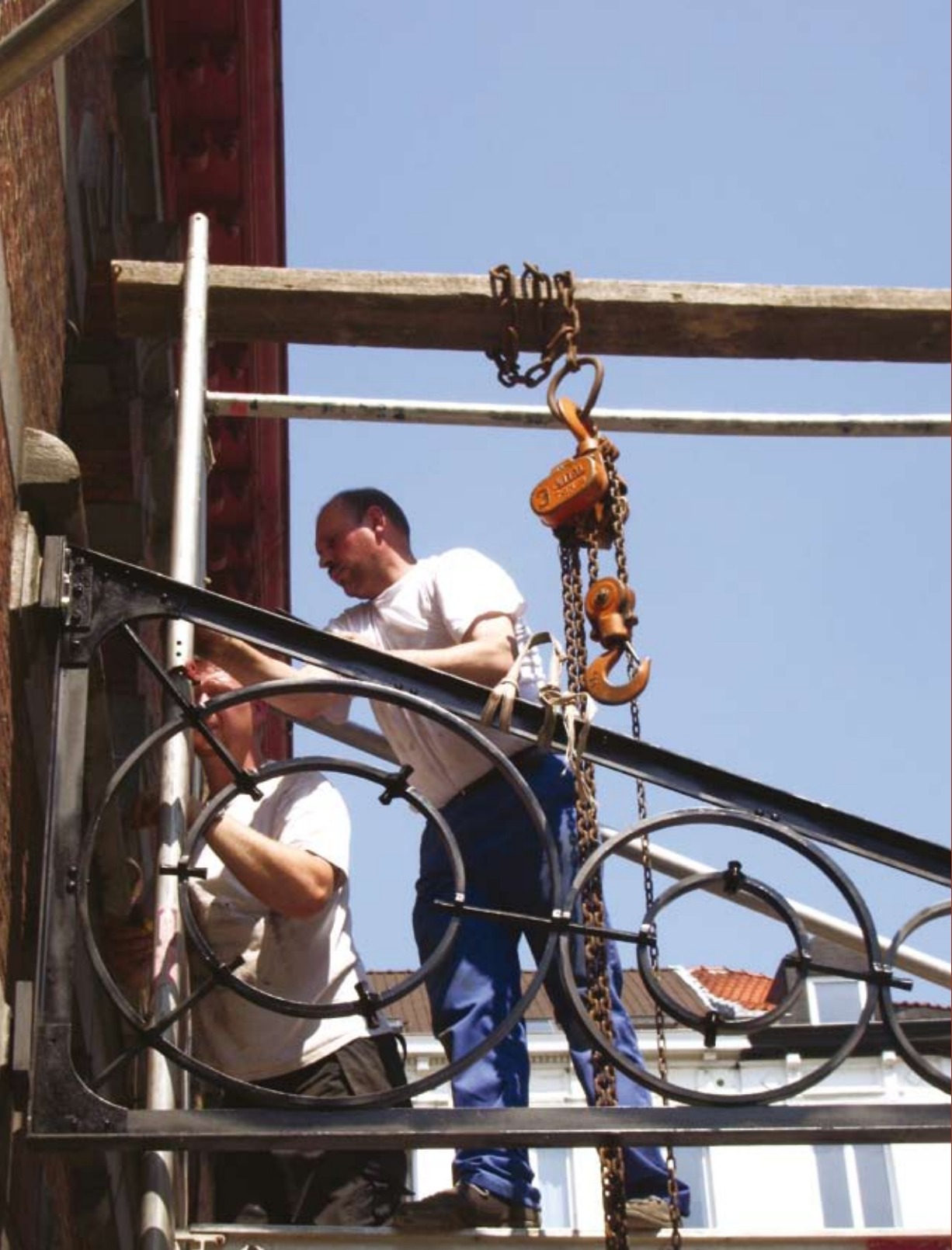
Reconstitution de la marquise des halles Saint-Géry à Bruxelles (photo Th. Wauters).
