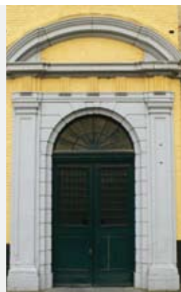
Cour d'honneur de l'abbaye de La Cambre à Bruxelles. Mise en couleur arbitraire du portail niant la valeur chromatique de l'édifice (photo de l'auteur).
