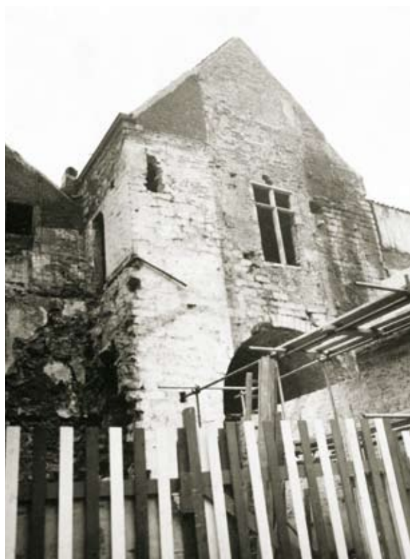
Tour intra-muros , juste avant l'intervention par J. Rombaux, 1959 (coll. Archives de la Ville de Bruxelles).
