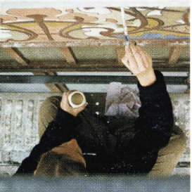
Chaussée de Wavre 519 Etterbeek Restauration des sgraffites de G. Strauven
