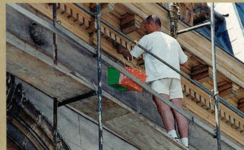
Remise en peinture d'une corniche après décapage complet Rue de l'Arbre Bénit 123, à Ixelles
