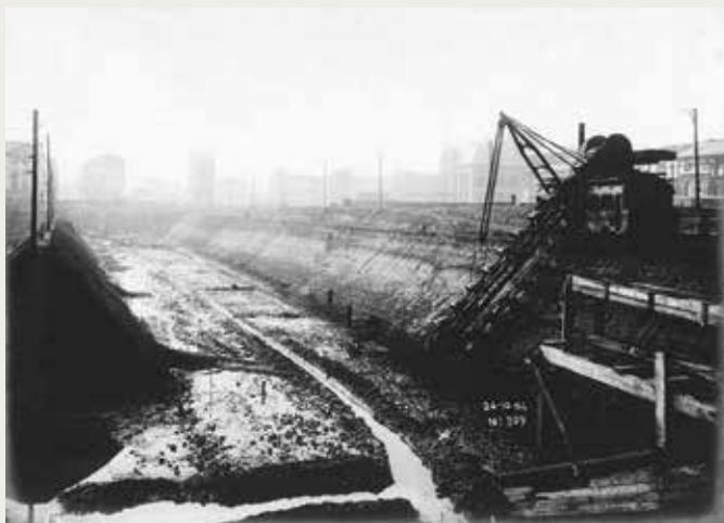
Dans la seconde partie des fouilles de l'entrepôt, installation et mise en marche d'un excavateur, drague dont la chaîne à godets, mise en mouvement par une machine à vapeur, entame le talus en y creusant des sillons. Les godets de la chaîne qui se sont remplis de terre et de déblais viennent se vider derrière l'excavateur.
