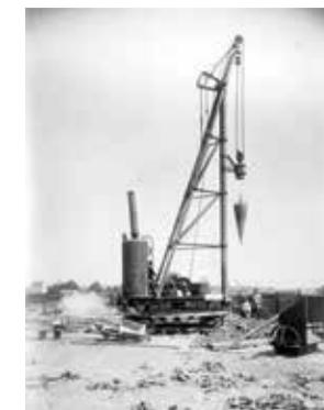
Charpente en bois ou en métal, la sonnette sert au guidage d'une lourde masse de fer ou de fonte appelée mouton. Levé à une hauteur de plusieurs mètres par une machine à vapeur, puis lâché en chute libre, celui-ci, de la force de ses 1.200 kg, enfonce progressivement dans le sol les pilots, longs pieux de bois destinés à assurer la stabilité des fondations dans le sol très humide du site.
