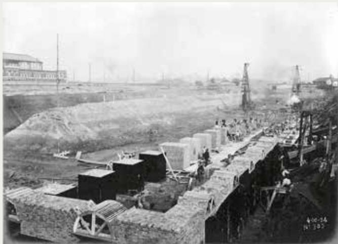
Les premiers pilastres en maçonnerie de l'entrepôt public en cours de construction alors que plus loin les sonnettes battent les pilots des fondations.
