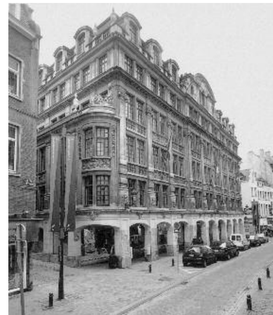
L'architecte M. Polak a choisi une architecture citant le vocabulaire baroque de la Grande Boucherie pour ce bâtiment qui la remplace, à front de l'actuelle rue Marché aux Herbes.
