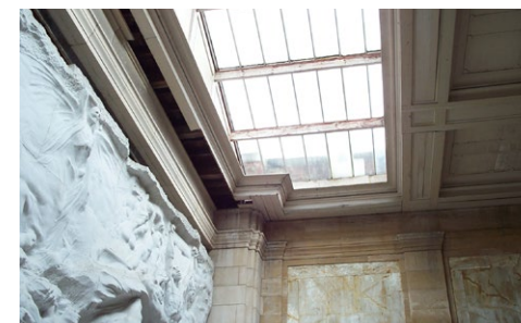
Verrière avant les travaux de restauration, 2002*.
