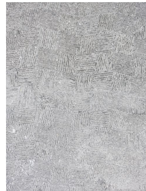
Taille des pierres du nouveau palier d'accès, 2014*.
