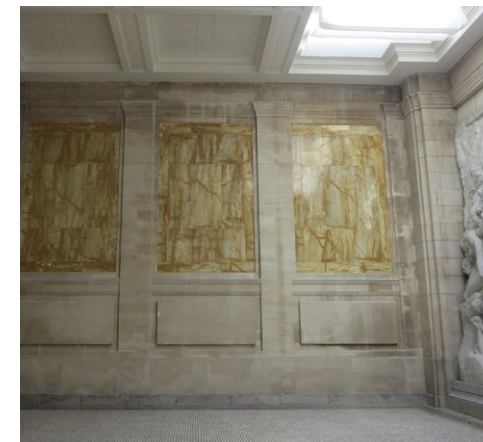
Vue intérieure, après restauration, 2014*.
