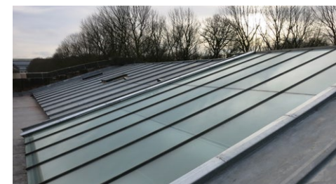
Toiture après les travaux de restauration, 2014*.
