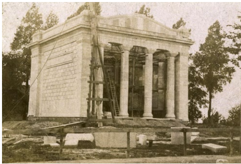
Pavillon des Passions humaines, arch. Victor Horta, avant 1893. Vue durant la construction : le relief n'est pas encore en place (on aperçoit le mur de briques au fond), les chapiteaux ne sont pas encore sculptés et le pavillon n'est pas encore couvert d'une toiture. (© AMH)
