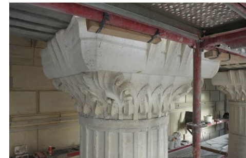
Chapiteau en pierre d'Euville après restauration, 2014*.
