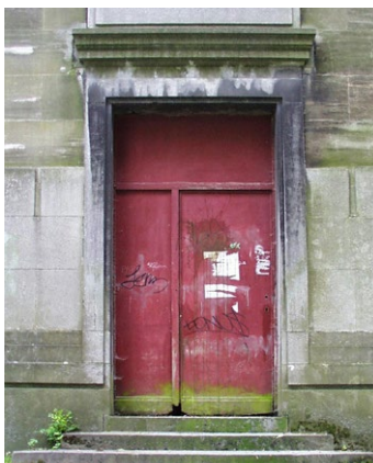
Porte arrière, avant restauration, 2003*.
