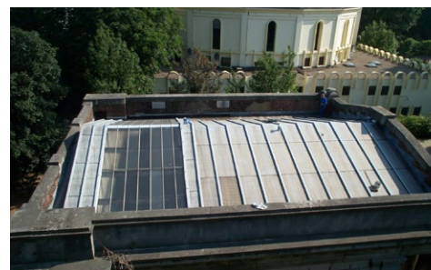
Toiture avant les travaux de restauration, 2002*.
