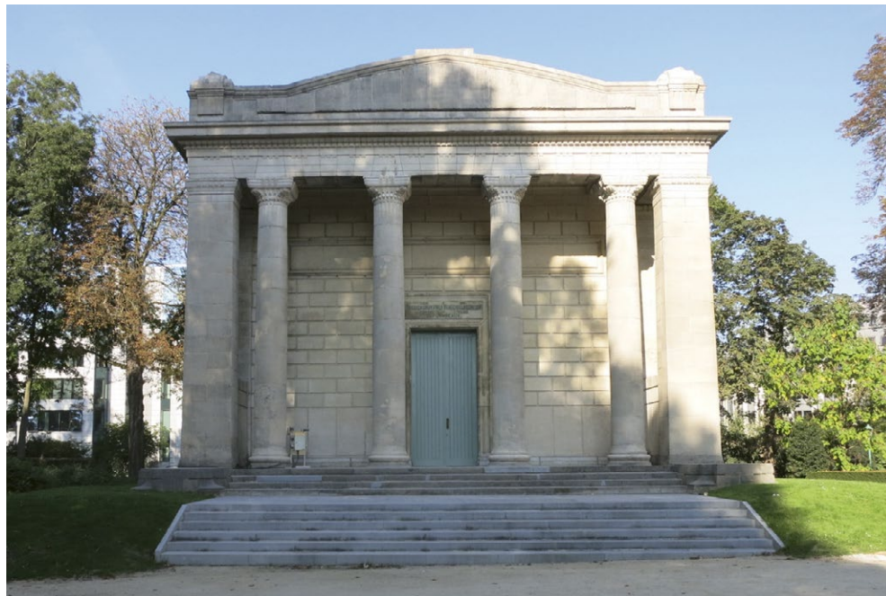
Vue extérieure, après restauration, 2014*.
