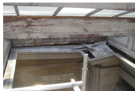
Verrière avant les travaux de restauration, 2005*.
