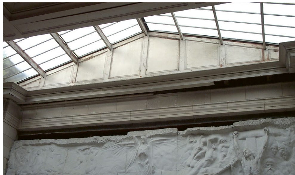
Le Pavillon des Passions humaines, arch. Victor Horta. Vue intérieure, avant restauration, 2003. Le parement en pierre situé juste au-dessus du haut-relief a été démonté en 1980. (© Régie des Bâtiments)
