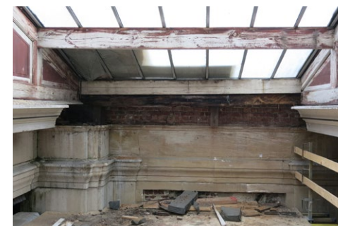
Verrière pendant les travaux de restauration, 2013*.
