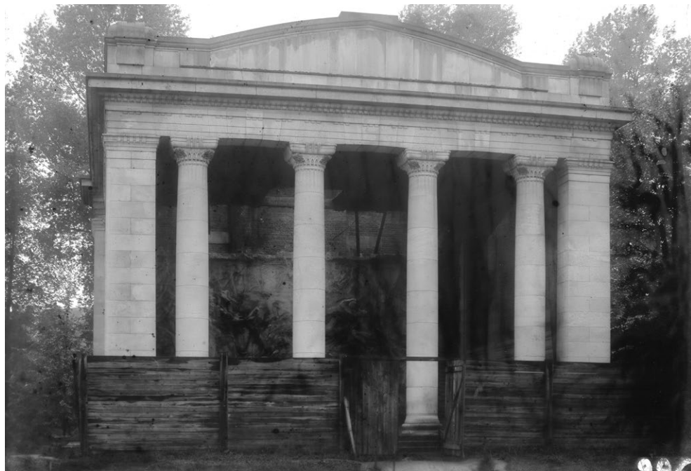
Pavillon des Passions humaines, arch. Victor Horta, 1904-1905 Le pavillon est rendu inaccessible par la construction d'une palissade en bois. Le lanterneau est occulté pour ne laisser passer la lumière que par une ouverture centrale au droit du relief. (© Régie des Bâtiments - Fonds ministère des Travaux publics)
