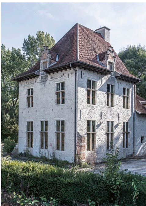
Le Slot à Woluwe-Saint-Lambert, état actuel. (A. de Ville de Goyet, 2019 © urban.brussels)
