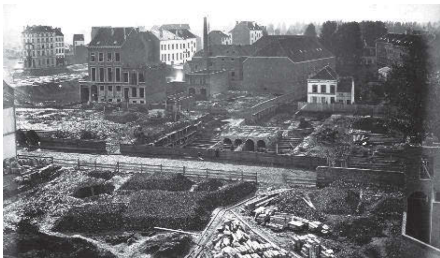
Vue sur le chantier du voûtement de la Senne, à l'intersection des actuels boulevards du Midi et Lemonnier. Photographie attribuée à J. Kampfe, 1870.
