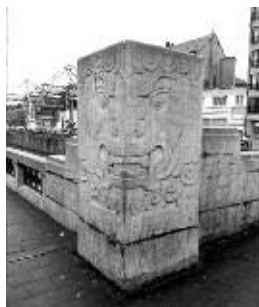
Pilier du pont de la porte de Flandre, construit sur les plans de V. Rogister.
