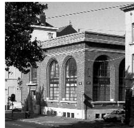
Ancienne sous-station électrique, édifiée en 1930.
