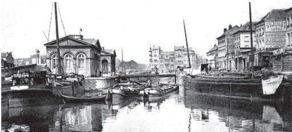
Vue générale de la place Sainctelette prise depuis l'Entrepôt, vers 1905. À gauche, les pavillons d'octroi de l'ancienne porte du Rivage.
