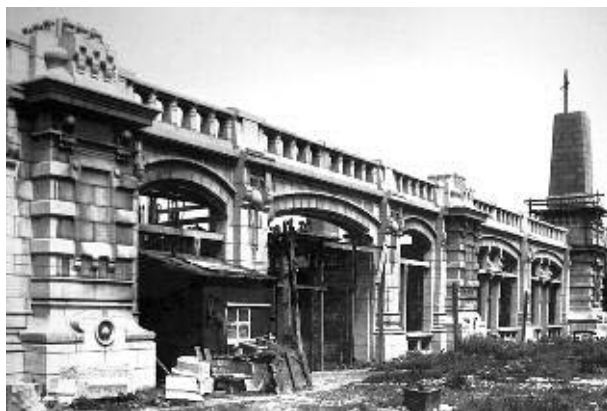
Construction des arches du viaduc de la jonction Nord-Midi.
