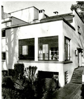
Le n°292. Cette petite maison, édifée pour le professeur Grégoire Lagasse par H. van de Velde (1933) atteste de la curiosité d'esprit et du renouvellement constant dont fait preuve cet architecte au cours de sa longue carrière. En effet, les murs blancs dénués de tout ornement, la terrasse et le toit plat, de même que l'ordonnance intelligente des volumes intérieurs inscrivent cette maison dans le courant moderniste des années 30.
