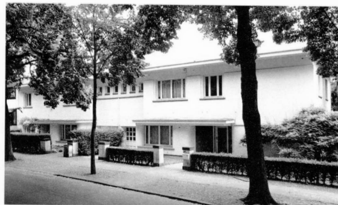
Avenue Circulaire n° 118 et 120. Rationalité et symétrie sont de mise pour ces œuvres de l'architecte G. Ricquier.
