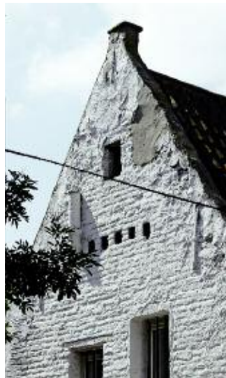
L'hof ter Cawerschueren à Woluwe-Saint-Lambert. Détail du pignon avec boulins pour les pigeons.
