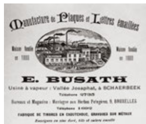
Les usines de plaques émaillées Busath sont installées dès la fin du XIX e siècle dans un édifice du XVI e siècle. La manufacture se trouvait approximativement à l'emplacement du mini golf actuel.
