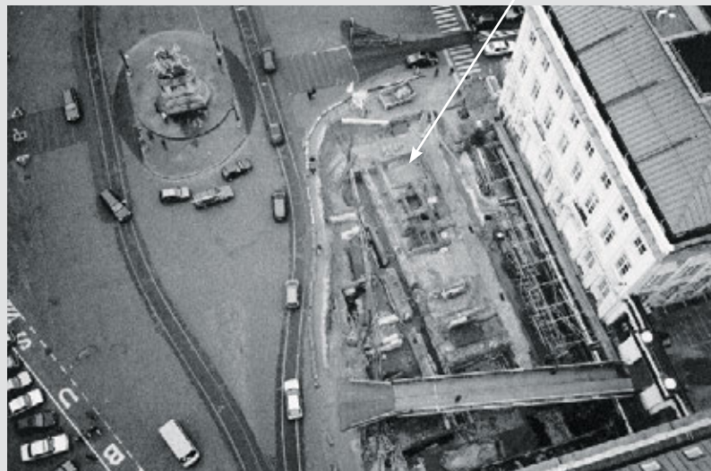
Vue aérienne des fouilles de l'Aula Magna et de la rue Isabelle.
