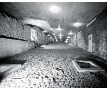
Vue actuelle de la rue Isabelle sous la place. La rue est bordée des fondations des hôtels du XVIII e siècle.
