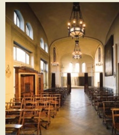
Trois stades de la construction de la chapelle entre 1912 et janvier 1913. (photo R.V. Duquenne, ACPASB)
