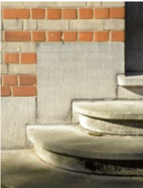
De haut en bas, détails du couronnement, des sommiers, des seuils de fenêtre et de porte d'un pavillon de médecine des adultes.
