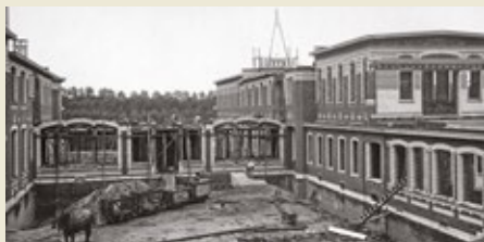
Vue des pavillons de chirurgie [C6] en construction. (photo R.V. Duquenne, ACPASB)
