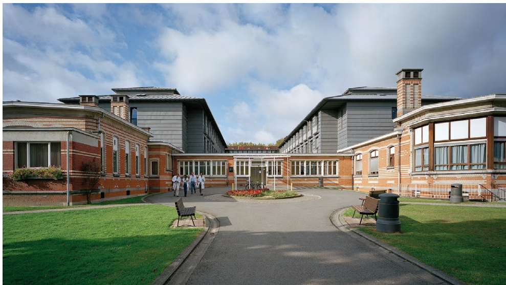
Les nouvelles ailes d'hospitalisation. (projet Philippe Samyn & Partners, photo M.-Fr. Plissart)
