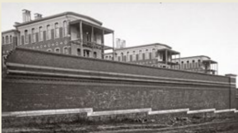
Les terrasses en belvédère des salles de chirurgie orientées vers l'ouest. (photo R.V. Duquenne, ACPASB)
