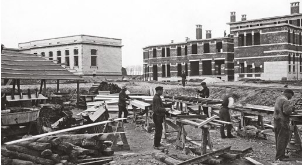
Le chantier de l'hôpital en avril 1912. (photo R.V. Duquenne, ACPASB)
