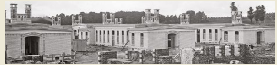
Les pavillons en construction avec leur forêt de cheminées de ventilation en toiture.
