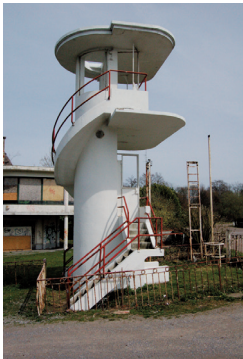
Fig. 9 Tour de départ, arch. Paul Breydel (photo de l'auteur, 2013).
