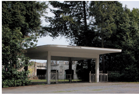
Fig. 7 Entrée du site de l'hippodrome, chaussée de la Hulpe 53 à Uccle, arch. Paul Breydel (photo de l'auteur, 2013).
